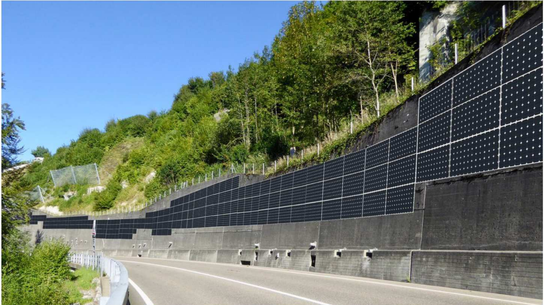
Visualisierung Photovoltaikanlage Umfahrung Teufen
