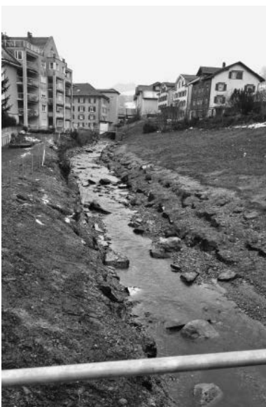
Herisau, Sägebach nach Sanierung
