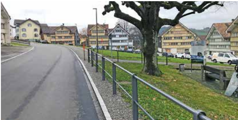
Bild 4 Hundwil, Erneuerung Urnätscherstrasse
