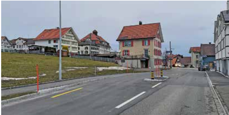
Bild 7 Speicher, Fussgängerquerung Brugg
