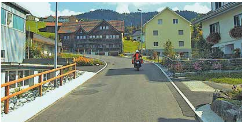
Bild 5 Schönengrund, Erneuerung Tüfenbergstrasse
