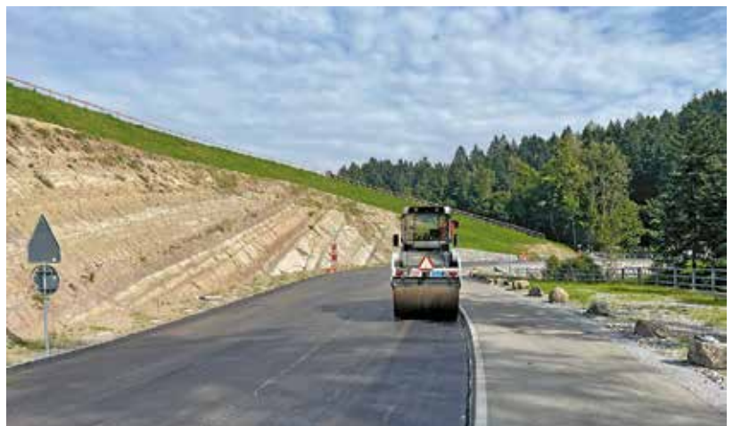
Bild 1 Kantonsstrasse Nr. 16, Trogen-Heiden, Nasenrank bis Kaien in Rehetobel, Ausbau mit Rad- und Gehweg, Ausführung 2019-2022
