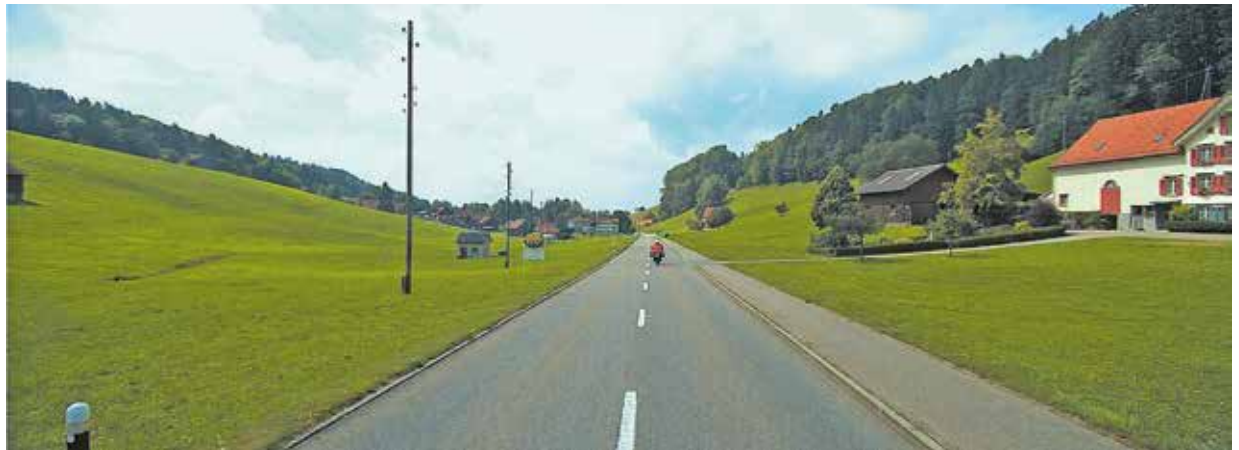
Bild 14 Längerfristiger Bedarf wegen fehlender zeitgemässer Veloinfrastruktur St.Gallen-Heiden auf der Kantonsstrasse Nr. 17, Heiden-Eggersriet.
