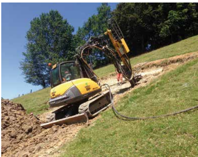
Sanierung nach Erdrutsch in der Mooshalde
