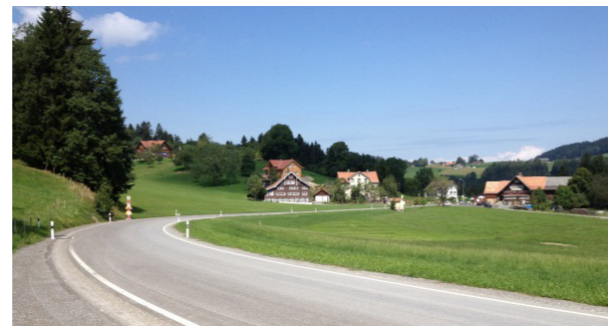
Bild 11: Steingocht - Knollhausen, Reute: Ausbau
