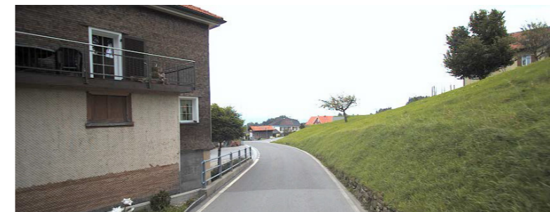
Bild 20: typische Lokalverbindungsstrasse im Vorderland mit ungenügenden Breiten und fehlender Entwässerung, Kantonsstrasse Nr. 54, Wolfhalden-Lachen-Walzenhausen, ein Kreuzen zweier PW ist kaum möglich. Die Gemeinde Walzenhausen wünscht einen Ausbau der Strecke. Da die Beläge jedoch erst vor wenigen Jahren erneuert wurden, ist ein Ausbau im vorliegenden Programm nicht vorgesehen.
