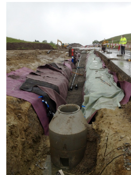
Bild 17: aufwändige Entwässerung mit Bentonitmatten in einer Grundwasserschutzzone bei Knollhusen, Reute.
