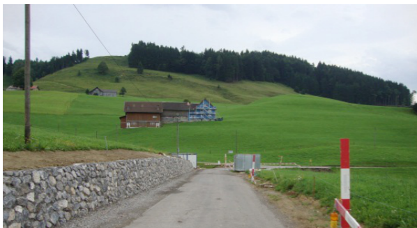
Bild 8: Munitionsdepot - Aeschen, Hundwil: Ausbau
