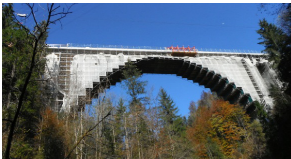
Bild 6: Stein/Teufen, Gmündertobelbrücke: Sanierung
