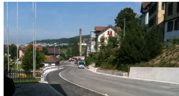
Bild 7: untere Steig, Herisau: Ausbau mit Trottoir
