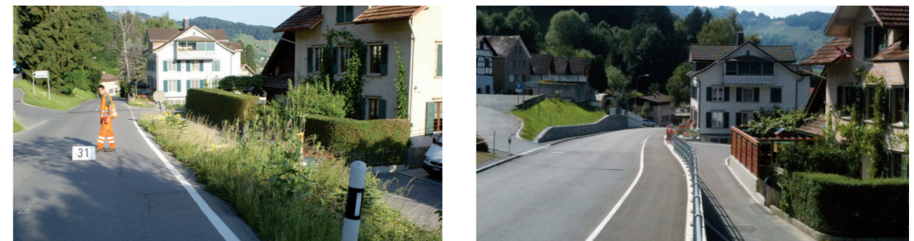
Bild 1 und 2: Kantonsstrasse Nr. 37, Thal-Lutzenberg, Abschnitt Kantonsgrenze - Haus Bischof, Lutzenberg. Ausbau mit Gehweg, Ausführung 2012-2013. Zustand vor und nach dem Ausbau.
