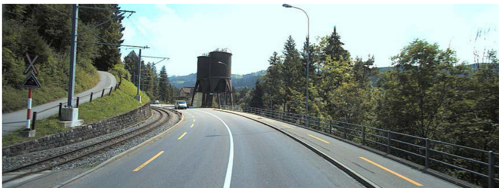
Bild 23: Längerfristiger Bedarf auf der Kantonsstrasse Nr. 12.5, Teufen - Bühler; Instandsetzung der Hangbrücke Strahlholz, Baujahr 1938, erste Sanierung 1980. Das Trottoir rechts ist auf einer Kragkonstruktion, die besonders witterungs- und somit korrosionsanfällig ist.
