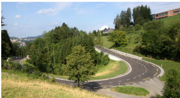
Bild 10: Gruenholz-Ortsanfang, Wald, Ausbau
