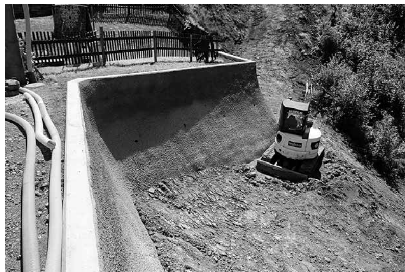
Gebäudeschutz nach Sanierung
