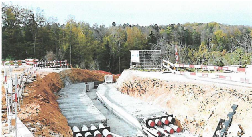
Abb. 1: Erdverkabelung nach SIA Norm 1, Quelle: Bauernzeitung
