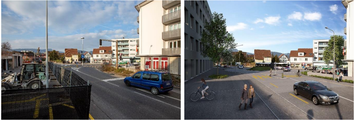
Abbildungen 10 und 11: K 242 Suhrerstrasse Aarau, Blick Richtung Knoten Bavaria, heute und Visualisierung
