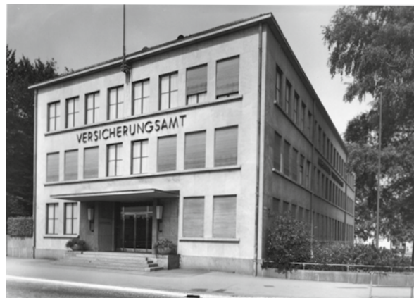
Altes AVA-Gebäude in Aarau
