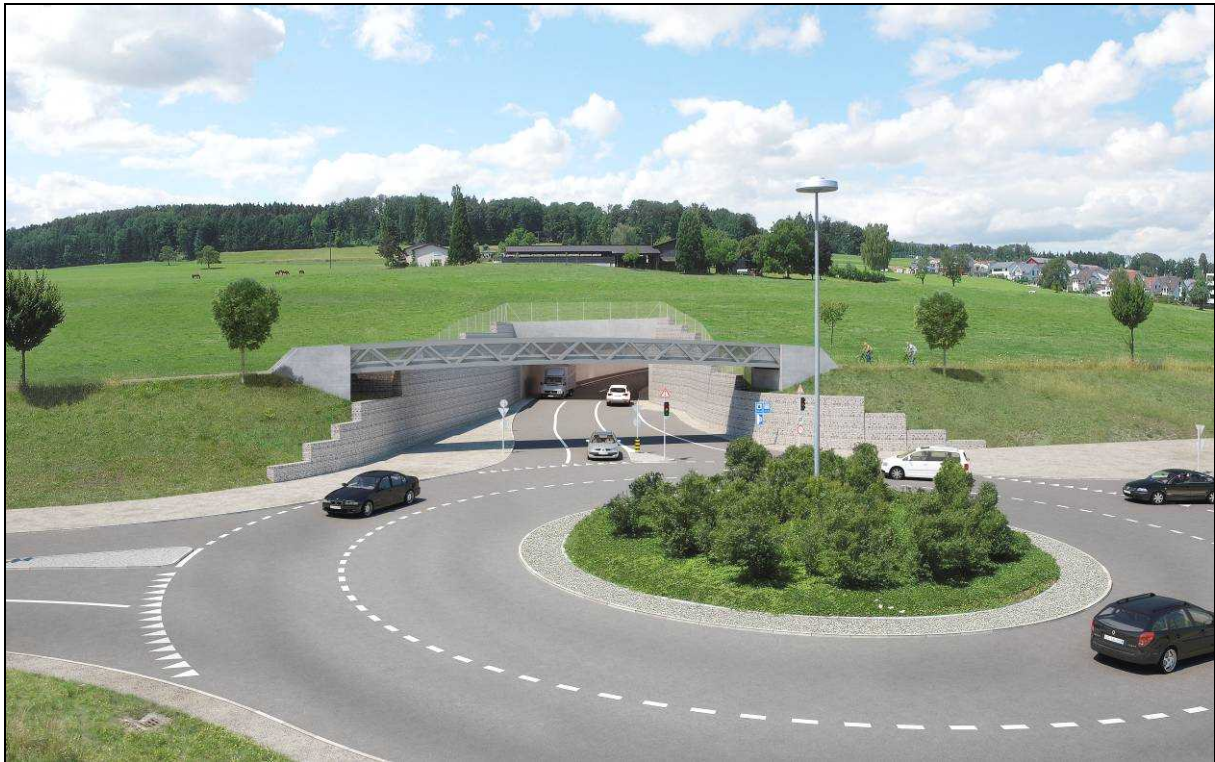
Abbildung 3: Südportal, Rad- und Fussgängerüberführung Schürmatt, Kreisel Süd
