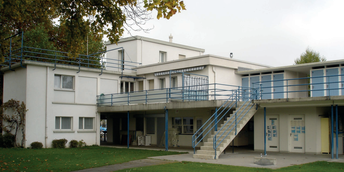
Haupttrakt vor der Sanierung
