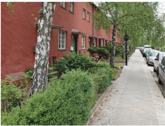
Vorzone als Vorgartenbereich zum Hochparterre
