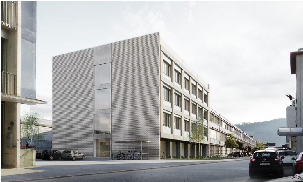
Blick von der Industriestrasse her auf die West- und die Südfassade.
