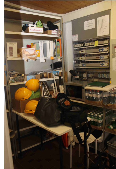
Lager- und Technikbereich
