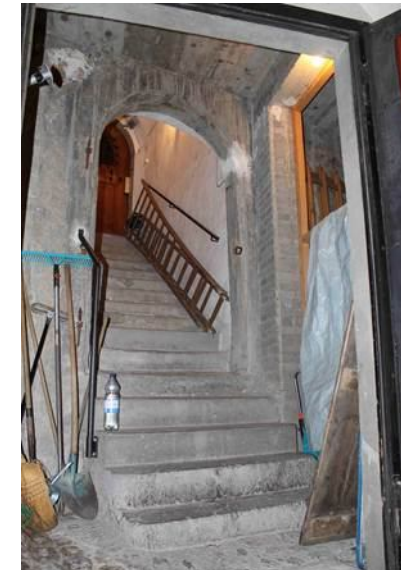
Neue Besucherführung: Eingang durch den Keller in den Donjon
