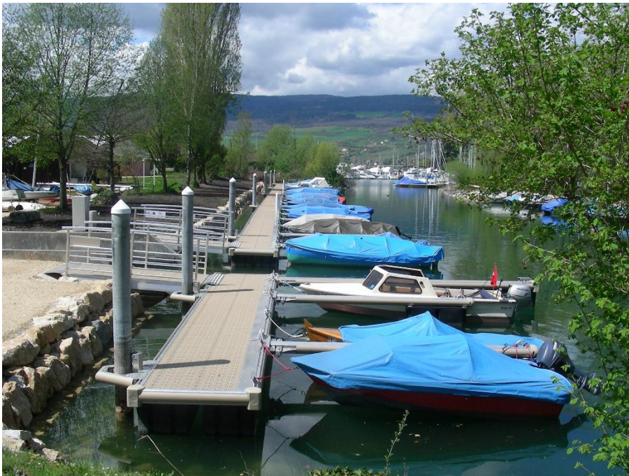
Foto 5: Beispiel Schwimmsteg am Ufer (Hafen Erlach, Projekt Bächtold & Moor AG)
