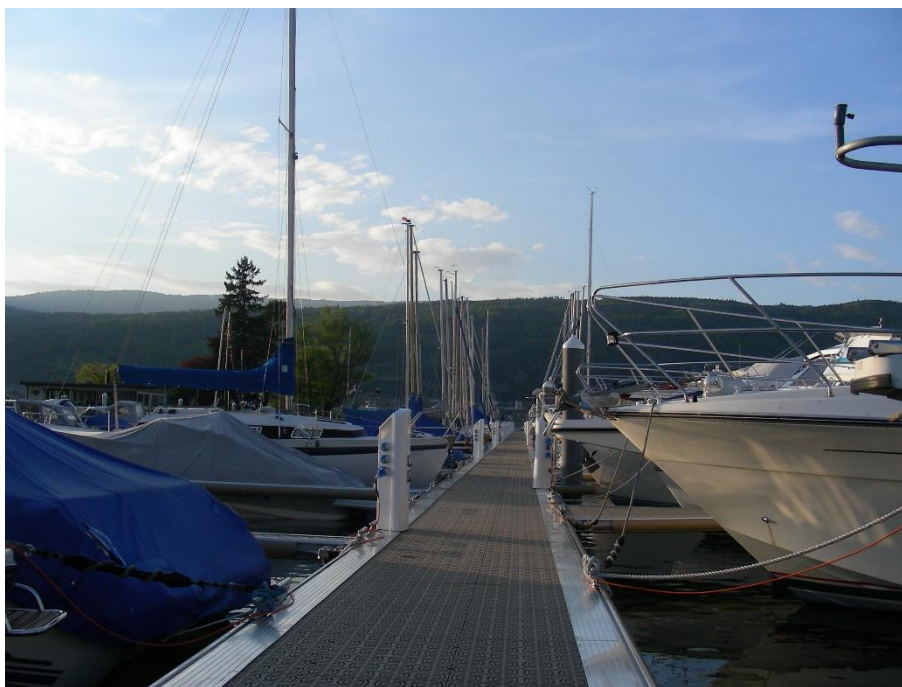
Foto 6: Beispiel Schwimmsteg beidseitig belegt (Hafen Erlach, Projekt Bächtold & Moor AG)
