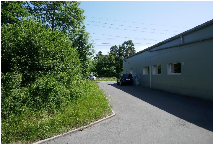
Abbildung 6-2: Sicht Richtung Bahngeleise auf die Fassade, an welche das neue Gebäude angebaut werden soll und den heutigen Waldrand der zu rodenden Fläche.
