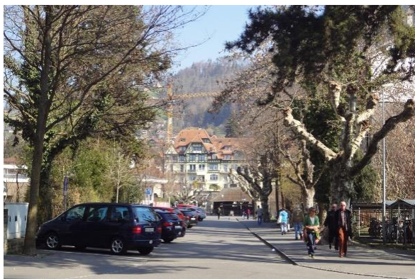
vor der Sanierung Parkplätze, Fahrbahn, schmales Trottoir
