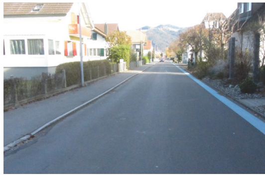
Einseitiges Trottoir in der Schulstrasse
