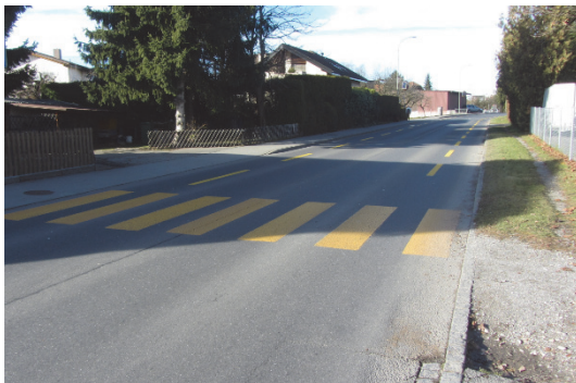
Fehlender Fussweg und mangelhafter Fussgängerübergang auf Pfandernstrasse
