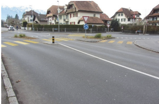
Bypass beim Kreisel Jungfraustrasse – Pestalozzistrasse, ein für den Veloverkehr gefährlicher Kreisel im Umfeld von Schulen
