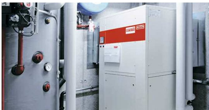
Baubewilligungsfreie Luft/Luft-Wärmepumpe mit Luftbezug im Haus
