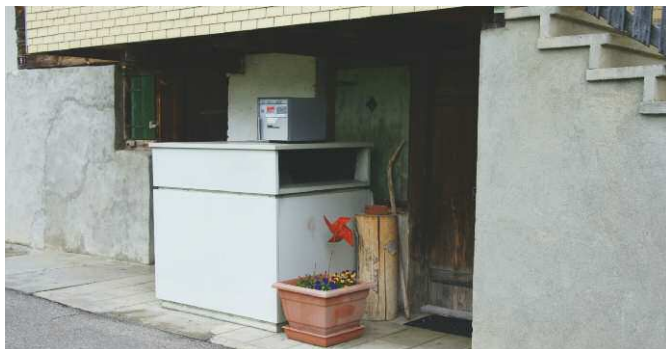
Baubewilligungspflichtige Luft/Luft-Wärmepumpe mit Luftbezug ausserhalb des Gebäudes
