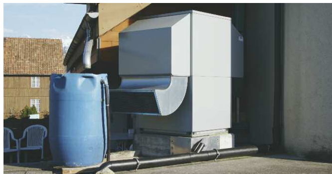
Baubewilligungspflichtige Luft/Luft-Wärmepumpe mit Luftbezug ausserhalb des Gebäudes
