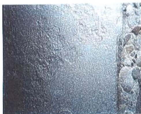
Sandgestrahlte Sohlendichtung (Stahl/Beton)
