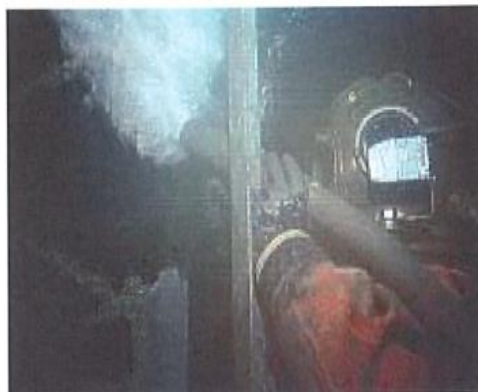
Taucher beim Sandstrahlen nach Hochdruckreinigung
