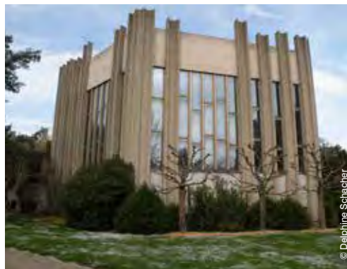
Le Centre funéraire de Saint-Georges nécessite une rénovation.
