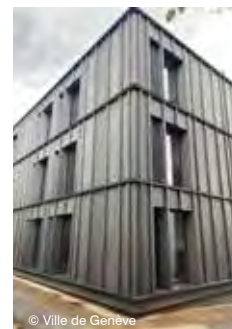
Mise en service des pavillons scolaires modulaires à Trembley
