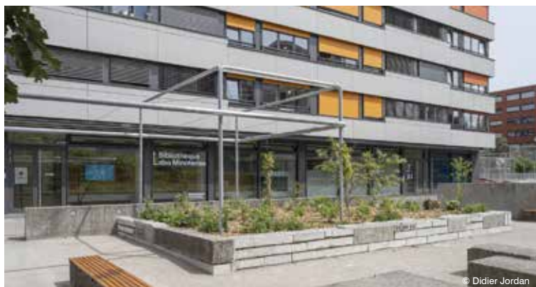
Bacs en béton recyclé aux Minoteries
