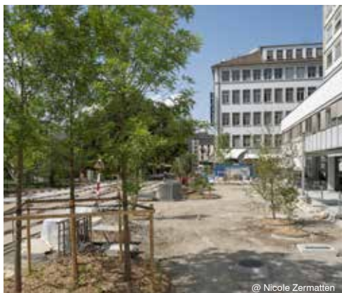
Aménagements publics rue des Rois
