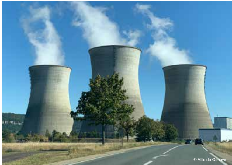
Centrale nucléaire du Bugey
