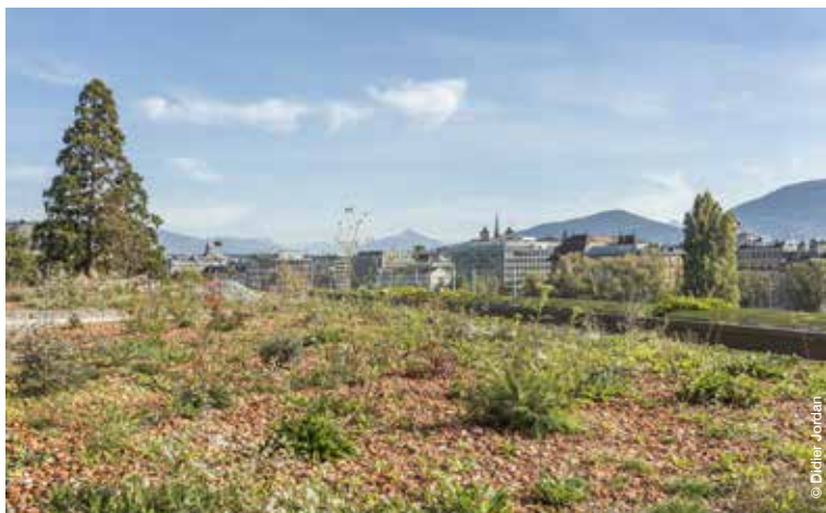
Toiture végétale à l'école du Seujet
