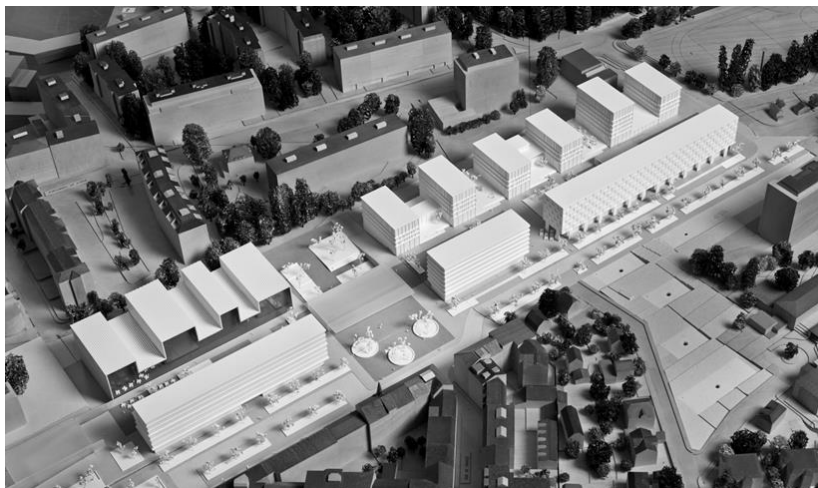
Vue de l'ensemble du périmètre de la gare des Eaux-Vives (maquette). La part Ville de Genève du lot BC est située sous les six immeubles d'habitation (FVGLS) en haut à droite de l'image.
