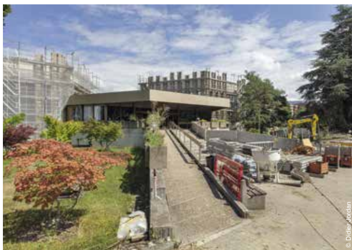
Les travaux de rénovation s'achèveront en 2027.
