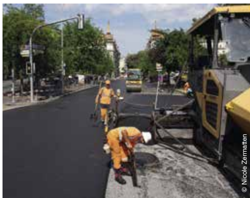
Entretien du revêtement routier sur Pictet-de-Rochemont
