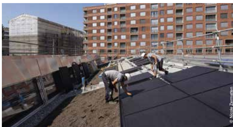
Pose de panneaux photovoltaïque sur l'école des Vernets
