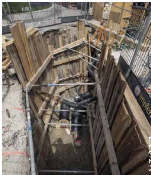
Entretien du réseau secondaire d'assainissement rue Pestalozzi
