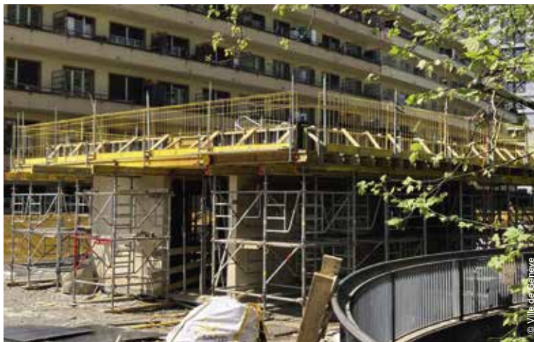
La construction en cours de la future guinguette.
