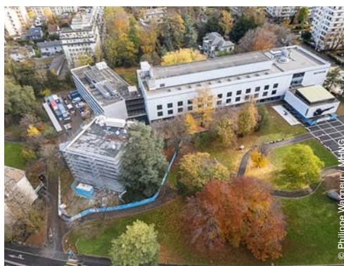
Vue du chantier Ambre du MHN en novembre 2024
