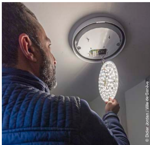
Grand-Rue 26: Installation d'un nouvel éclairage LED équipé d'un détecteur de présence
