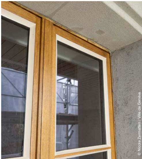
Clairière 19: Remplacement des simples vitrages par des vitrages isolants
