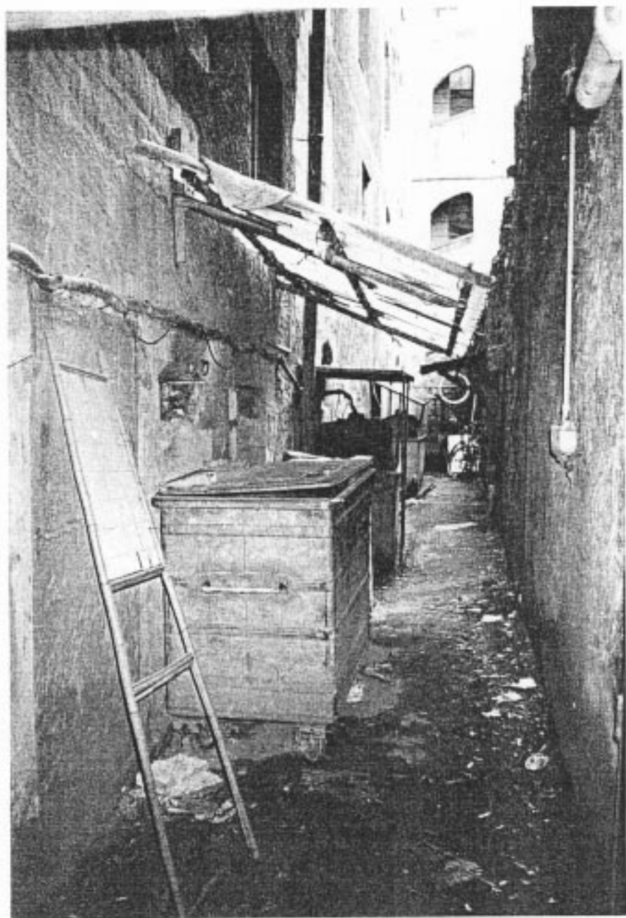
4. Façade cour - ruelle "Punaises"
