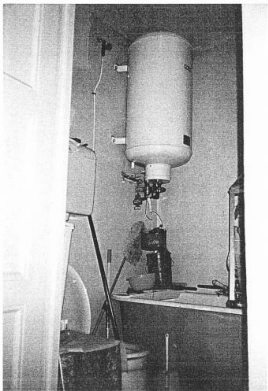
37. 1er étage / appt. "palier" - salle de bains
