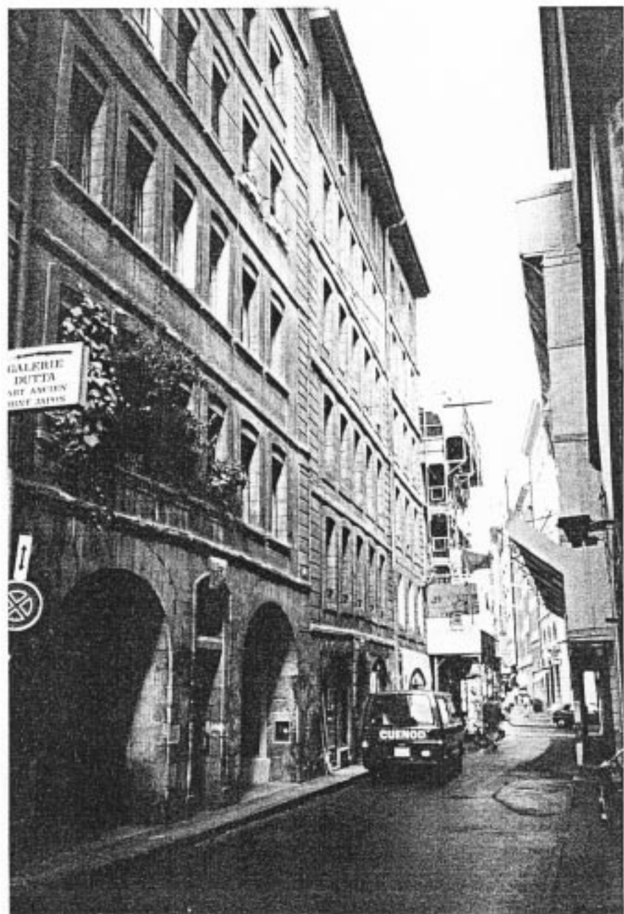
1. 17-19 rue des Etuves - Façade rue
