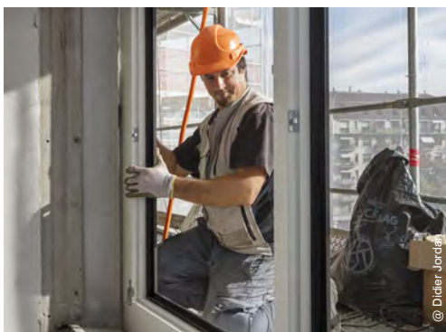
Chantier des Minoteries
