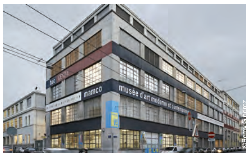
Bâtiment d'art contemporain (BAC)
