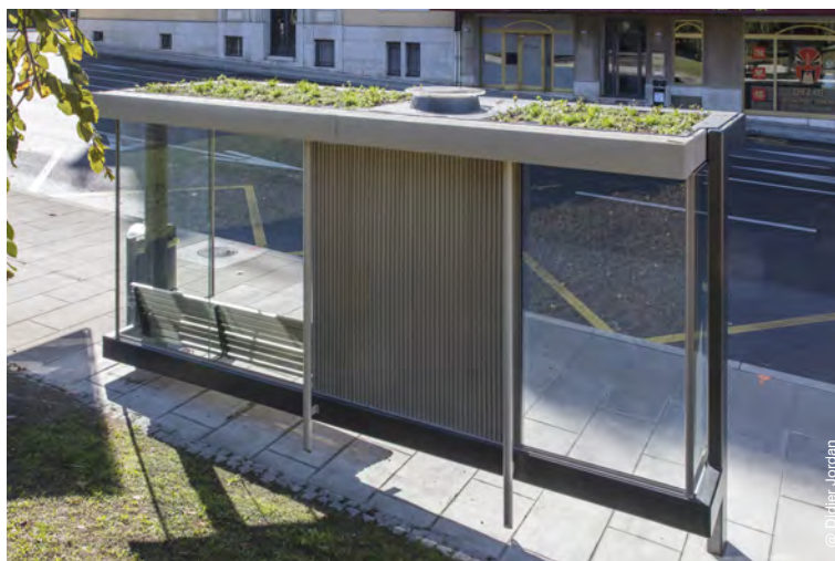
Prototype d'abribus végétalisé installé à l'arrêt Museum
