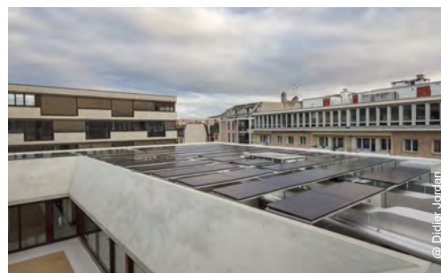
Panneaux solaires sur le toit du nouvel équipement public Marie Goegg-Pouchoulin
