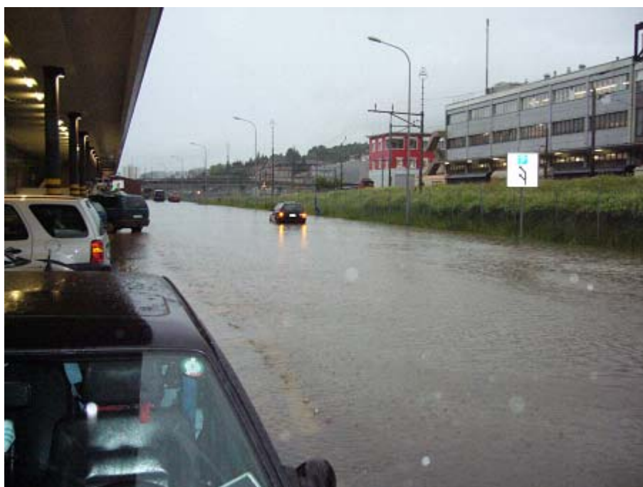
Photo 1 : Inondations 2006, secteur rue des Entrepôts
