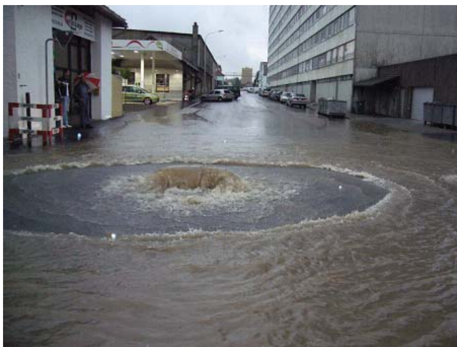
Photo 2 : Débordement collecteur en Ouest centre commercial, rue des Entrepôts
