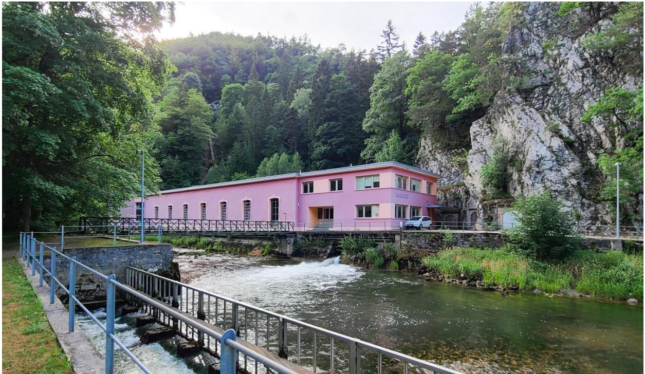
Figure 14 : Photographie de l'usine existante
