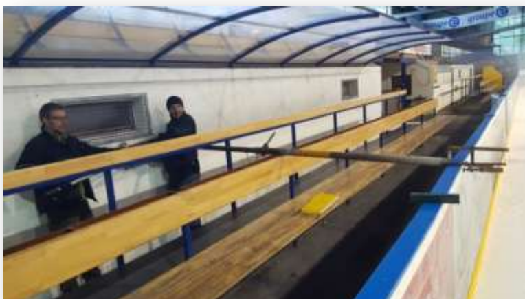
Photographie 2 : travaux ponctuels servant à redresser la bande
