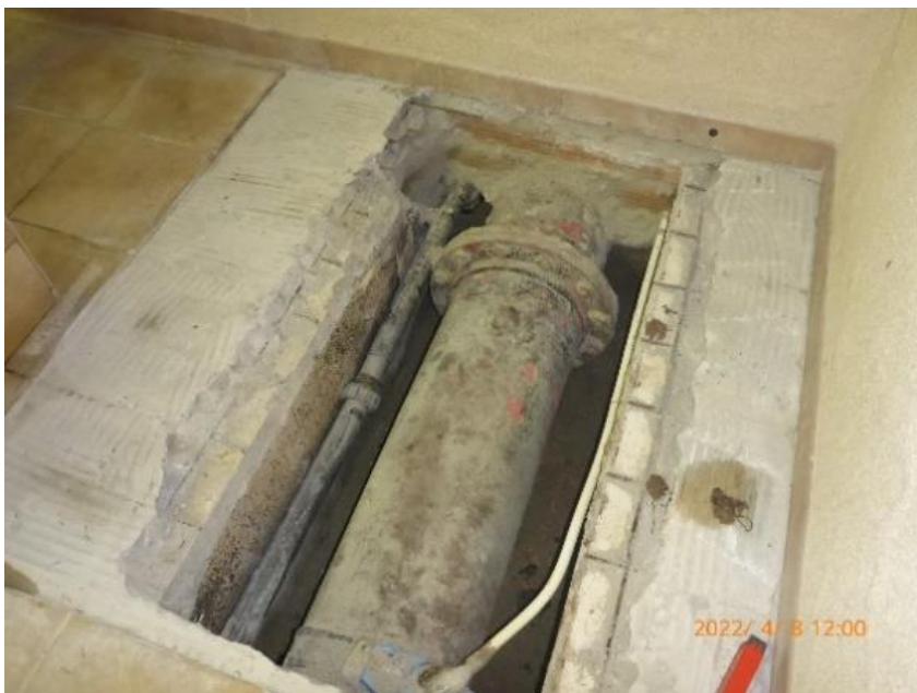
Sondage à l'intérieur de la station afin de retrouver la conduite d'aspiration On remarque deux couches de carrelage superposées.
