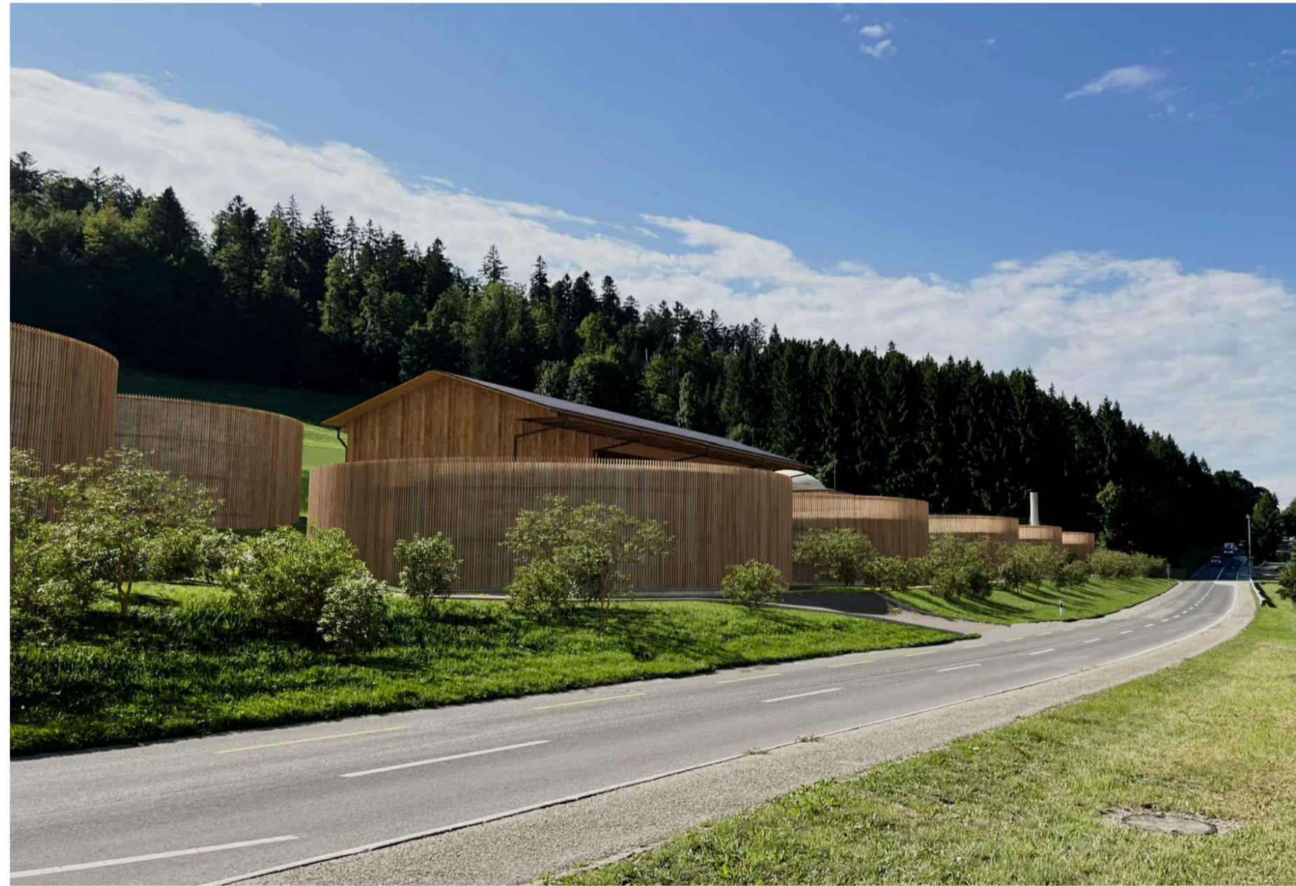
Biogaz, Vue Nord
