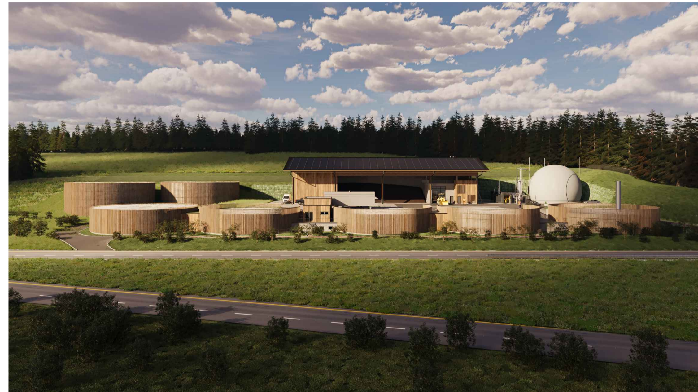
Biogaz, Vue Nord-Ouest
