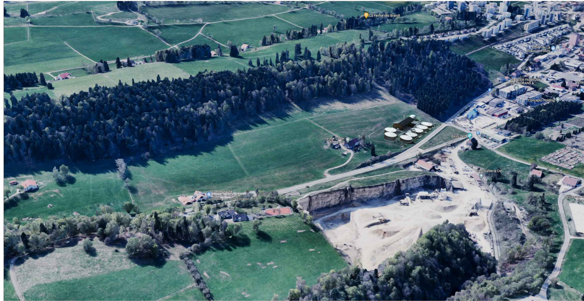
Biogaz, Vue Nord
