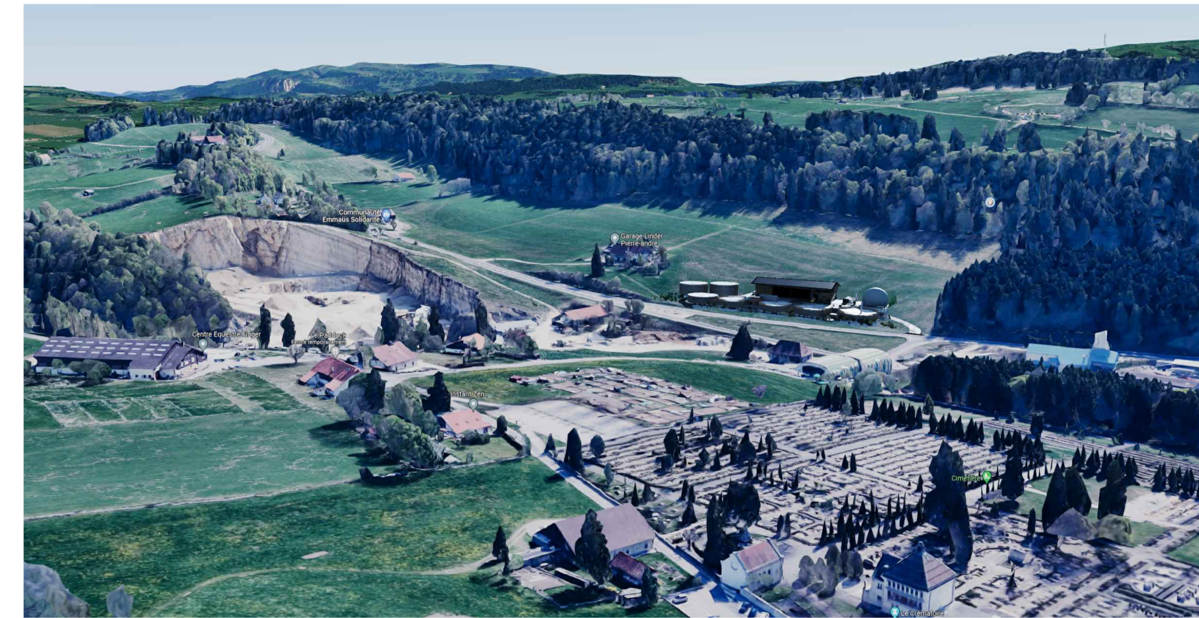
Biogaz, Vue Ouest
