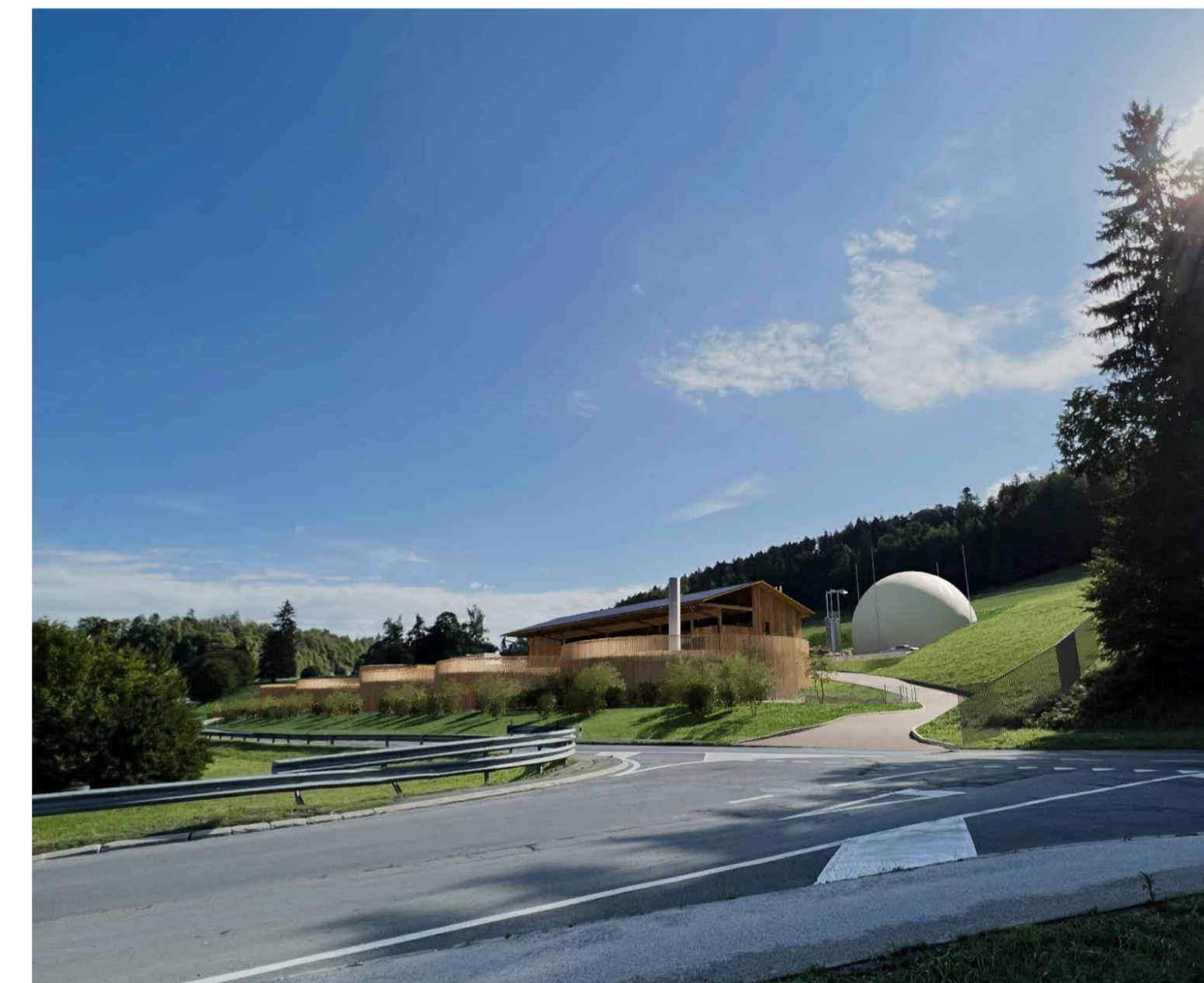
Biogaz, Vue Ouest
