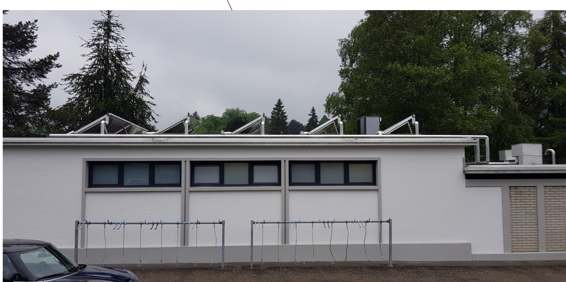
Vestiaires / WC / Douches - Rénovation en 2018
