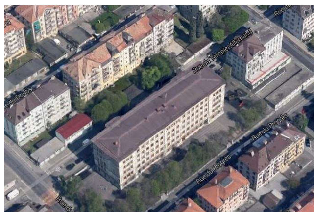
Façades Nord et Est
