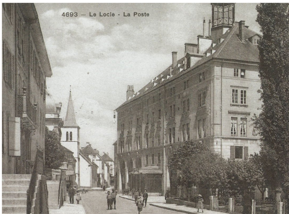
Comme à l'époque de l'Hôtel des Postes, le bâtiment Marie-Anne-Calame 5 structure la ville.
