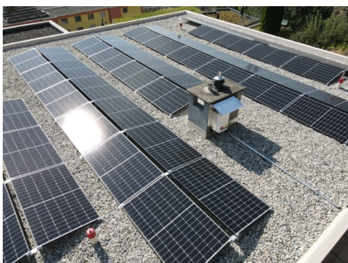
Figure 15 : Exemples d'installations solaires typiques en toitures plates
