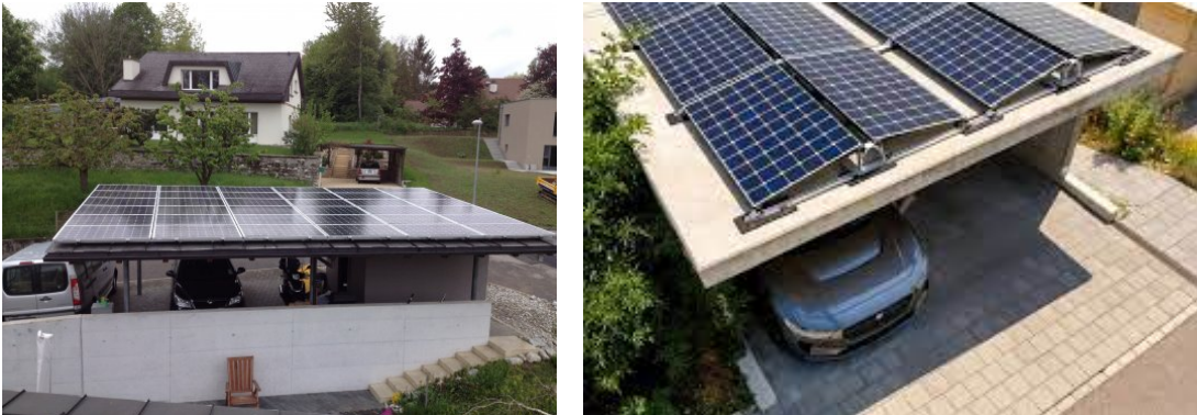
Figure 36 : Exemples d'installations solaires intégrées de modules colorés de format adapté à la trame de la toiture original
