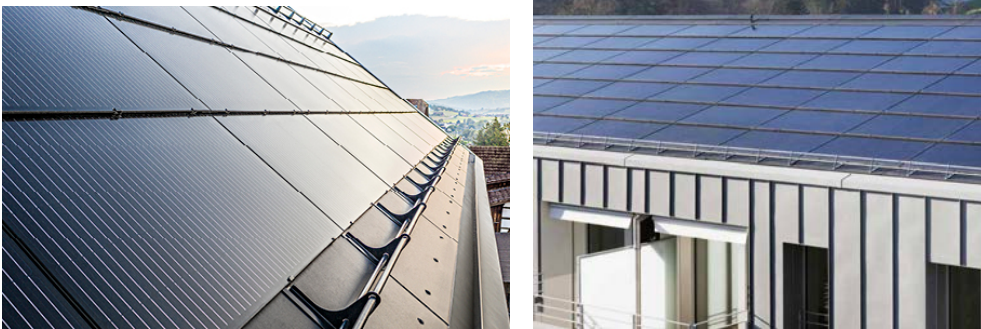
Figure 18 : Exemples d'installations solaires intégrées en toiture avec des modules noirs de formats standards (source : Eternit, Ernst Schweizer AG)
