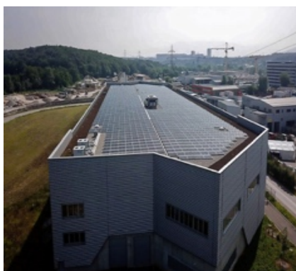
Figure 15 : Exemples d'installations solaires typiques en toitures plates
