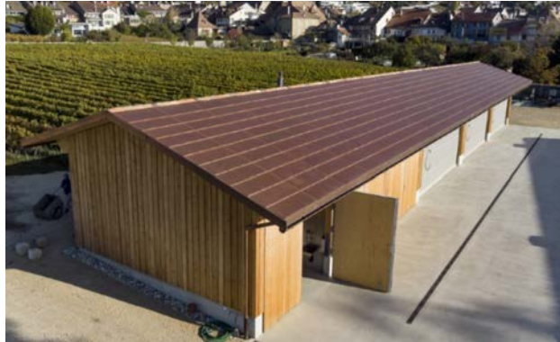
Figure 19 : Exemple d'installation solaire intégrée avec modules colorés de format adapté à la trame de la toiture original (source : Solaxess, LMNT).
