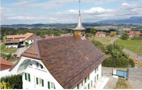
Figure 20 : Exemples d'installations solaires intégrées de modules colorés de format adapté à la trame de la toiture original (source : freesuns).
