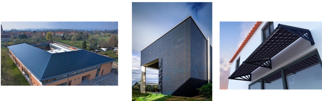
Figure 14 : Exemples d'installation BIPV en toiture, en façade et comme système d'ombrage/brise-soleil.
