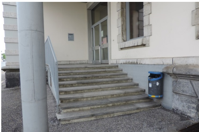
Marches extérieures - Entrée Nord
