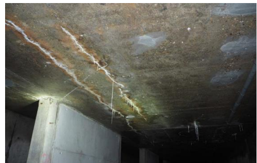
Figure 1 : Canal amont - présence de fissure longitudinale et transversale au niveau des joints de dilatation (partie gauche).
