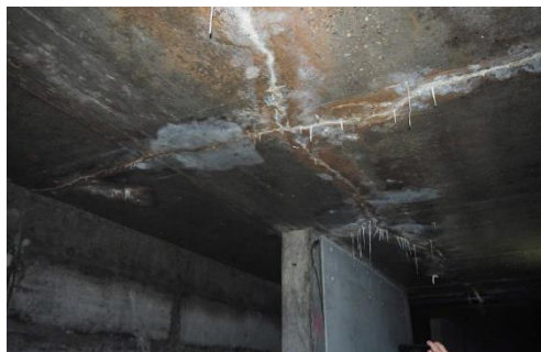
Figure 1 : Canal amont - présence de fissure longitudinale et transversale au niveau des joints de dilatation (partie gauche).
