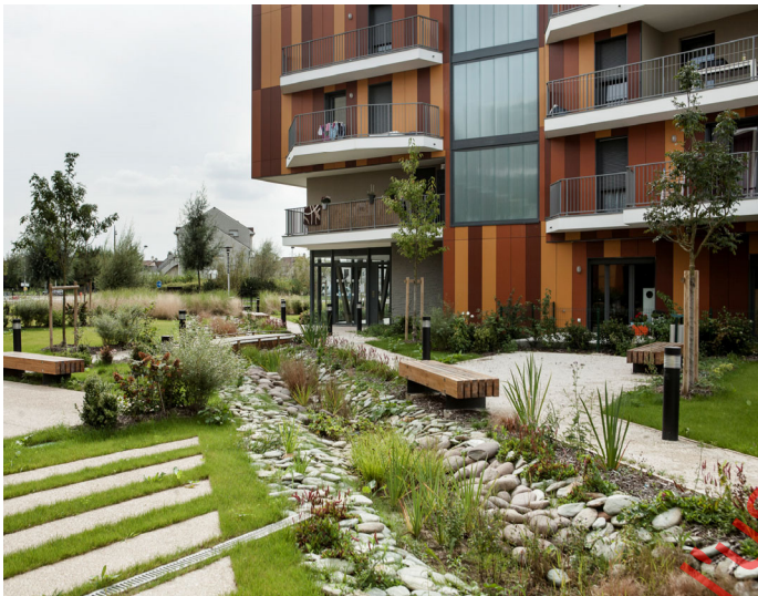
Figure 10 | Noue végétalisée et revêtements perméables
