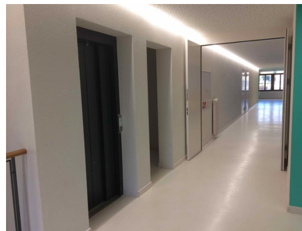
Ascenseur – Zone sanitaires
