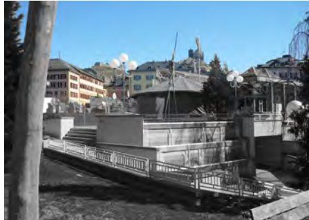
Fig.22 - Vue depuis l'Avenue de la Gare, le passage souterrain représente une forte obstruction physique et visuelle [xy-ar.ch, 2009]
