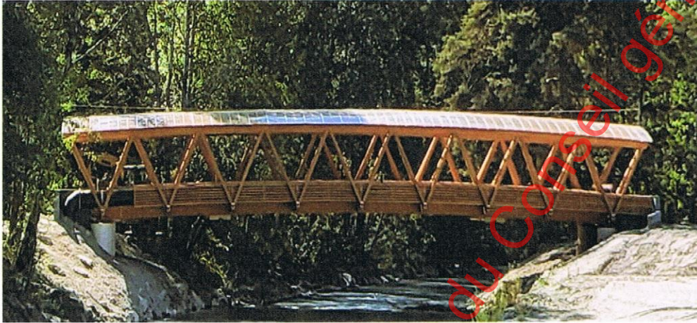
« Passerelle de la Borgne »
