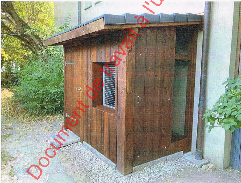
Image n°2 : Villa à Bramois, rue de Clodevis. APRÈS, avec autorisation du Service des Bâtiments et Constructions. Les travaux entrepris réduisent l'efficacité et compliquent les interventions sur la PAC tout en renchérissant le coût du projet. (Photographies publiées avec l'accord des propriétaires).
