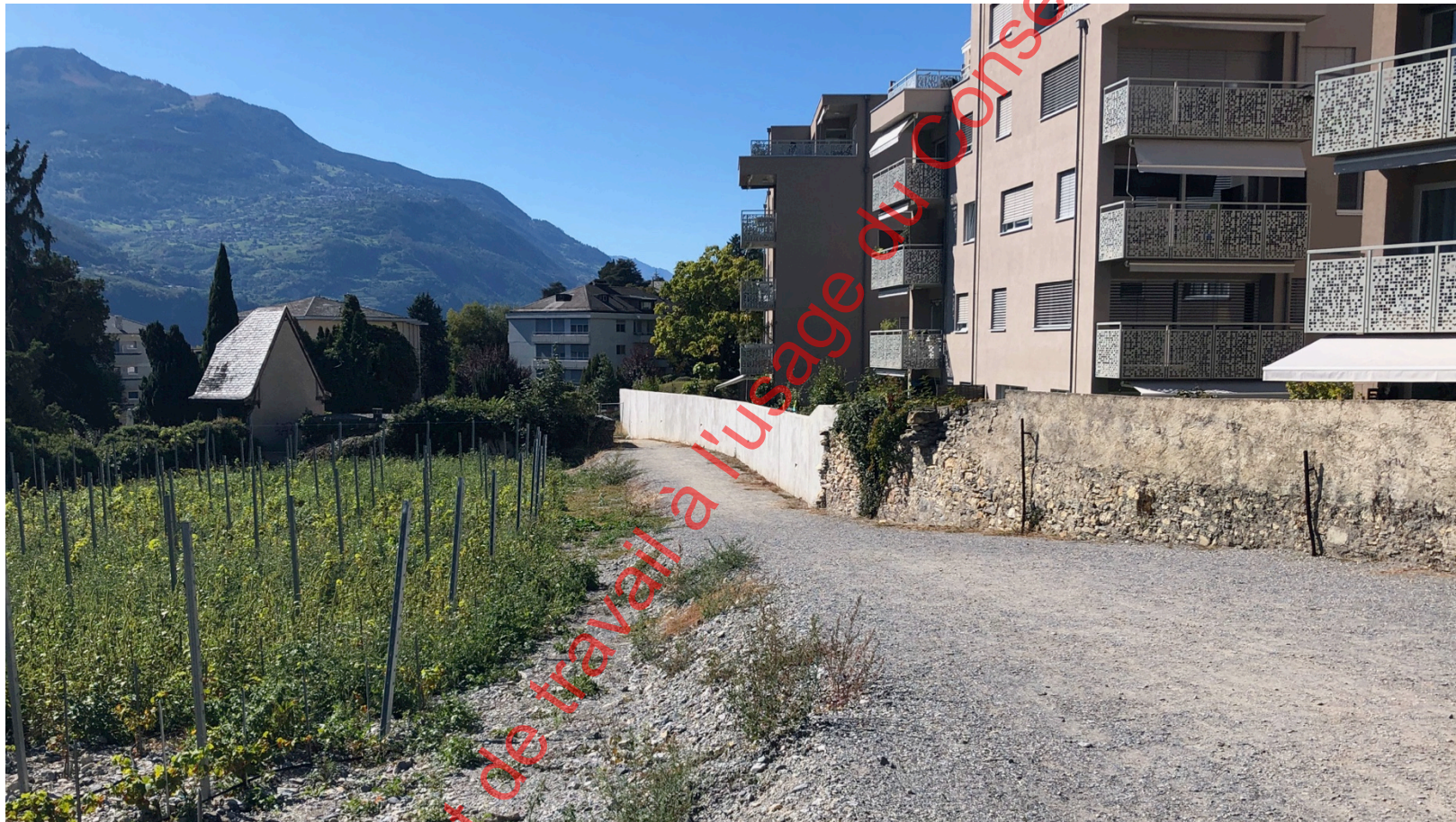
Passage des Capucins: le nouveau mur.
