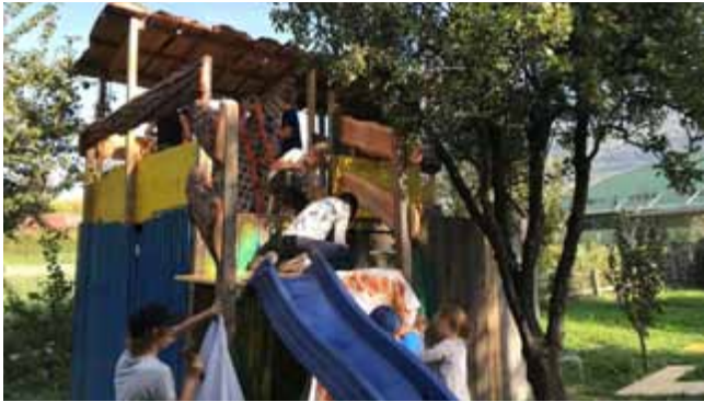
construction d'une cabane
