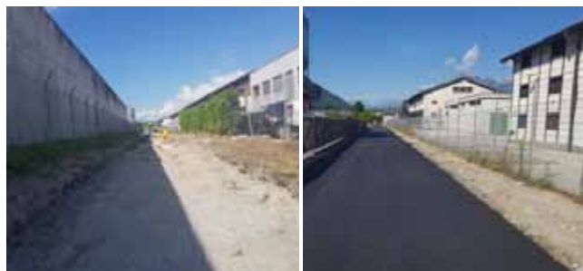
Travaux de réfection de chaussée au chemin de Grély
