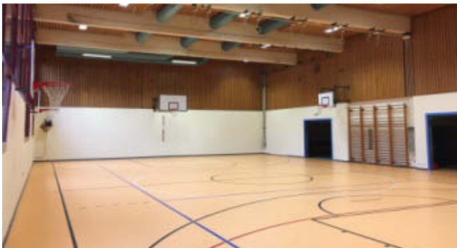
Les travaux comprennent la réfection de la salle de gym 2 du bâtiment I en raison des intempéries du 6 août 2018
