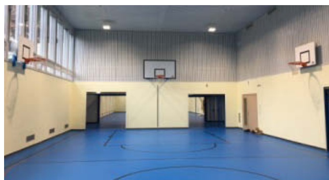
Les travaux comprennent la réfection de la salle de gym 2 et 3 en raison des intempéries du 6 août 2018 et le remplacement de l'éclairage des salles de gym par des sources lumineuses en leds.
