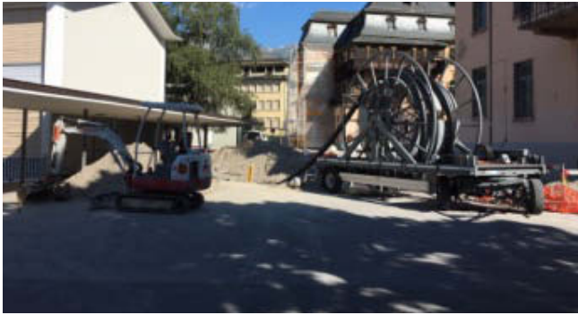
Remplacement des conduites à distance et dernière étape de la mise aux normes sismiques du bâtiment I
