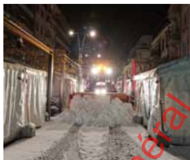
Opération de déneigement
