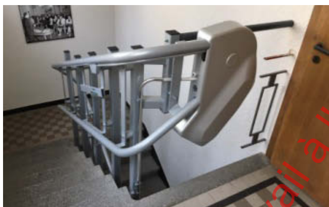
L'installation d'un lift – accès à la galerie de la salle du Grand Conseil pour personnes à mobilité réduite.
