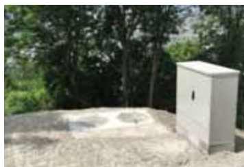
Arvillard - Création d'une station de relevage pour eaux usées
