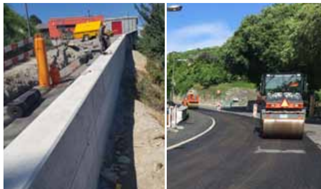
(Gauche) Chemin de la Crête à Bramois création d'un mur de soutènement et réfection de chaussée
