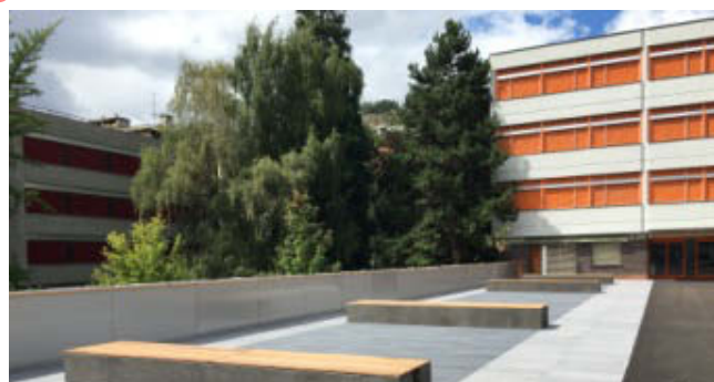
Les travaux engagés en 2018 comprennent l'isolation et la réfection complète de la toiture de liaison du bâtiment 39.
