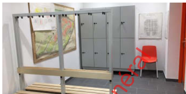
La réfection et l'assainissement du local de pause et vestiaires du personnel du centre funéraire de Platta..
