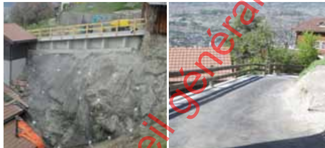
Chemin de la Forêt de l'Evêque à Salins - Ouvrage de soutènement de la route en encorbellement ancré dans le rocher et remise en état de la chaussée
