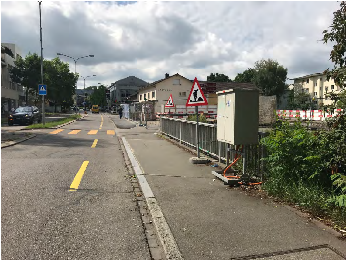
Foto 19 Brücke Altbach (km 27.220, Blickrichtung Kloten Bahnhof)
