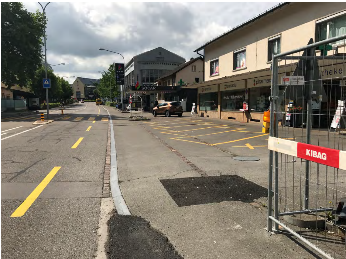
Foto 20 Parkplätze Schaffhauserstrasse Nr. 125 (km 27.170, Blickrichtung Kloten Bahnhof)
