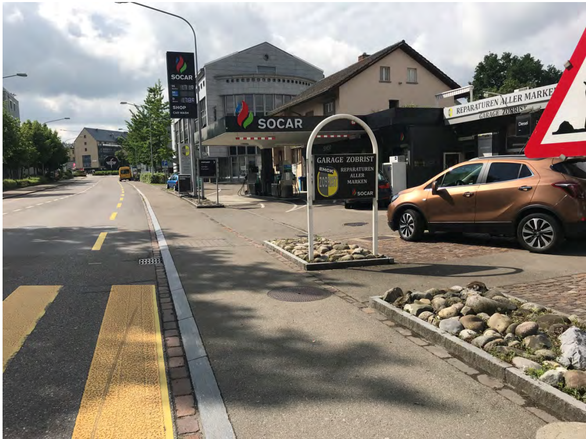
Foto 21 Schaffhauserstrasse Nr. 123, wird überbaut (km 27.140, Blickrichtung Kloten Bahnhof)
