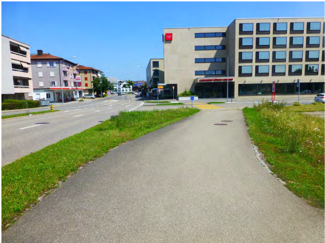
Foto 36 Flughafenstrasse Nr. 14 (km 27.450, Blickrichtung Bassersdorf)
