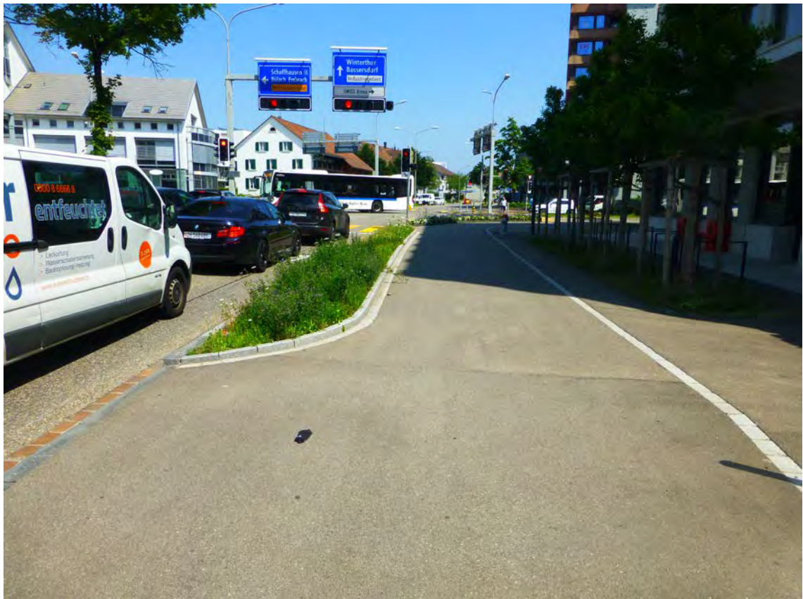
Foto 38 Flughafenstrasse Nr. 5 (km 27.450, Blickrichtung Bassersdorf)
