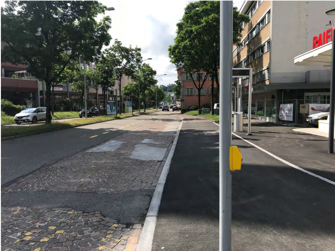
Foto 13 Bushaltestelle Zum Wilden Mann Süd (km 27.400, Blickrichtung Kloten Bahnhof)
