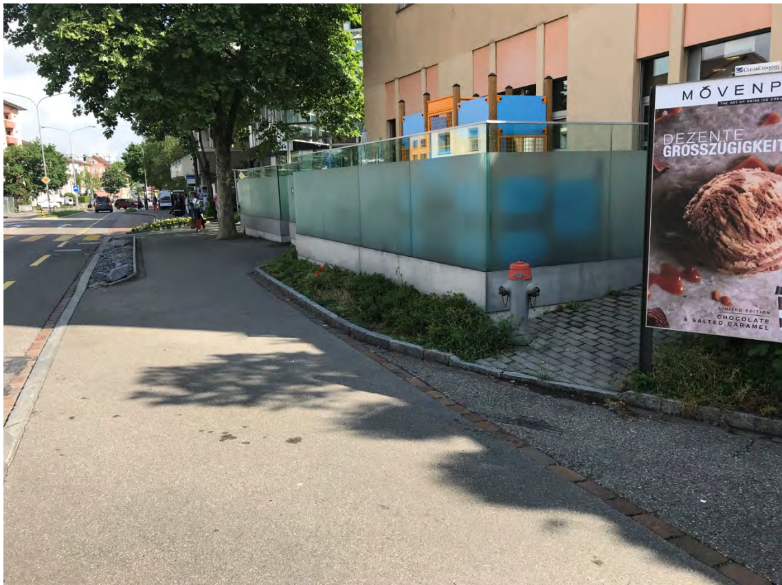
Foto 4 Terrasse Migros (km 27.110, Blickrichtung Bülach)
