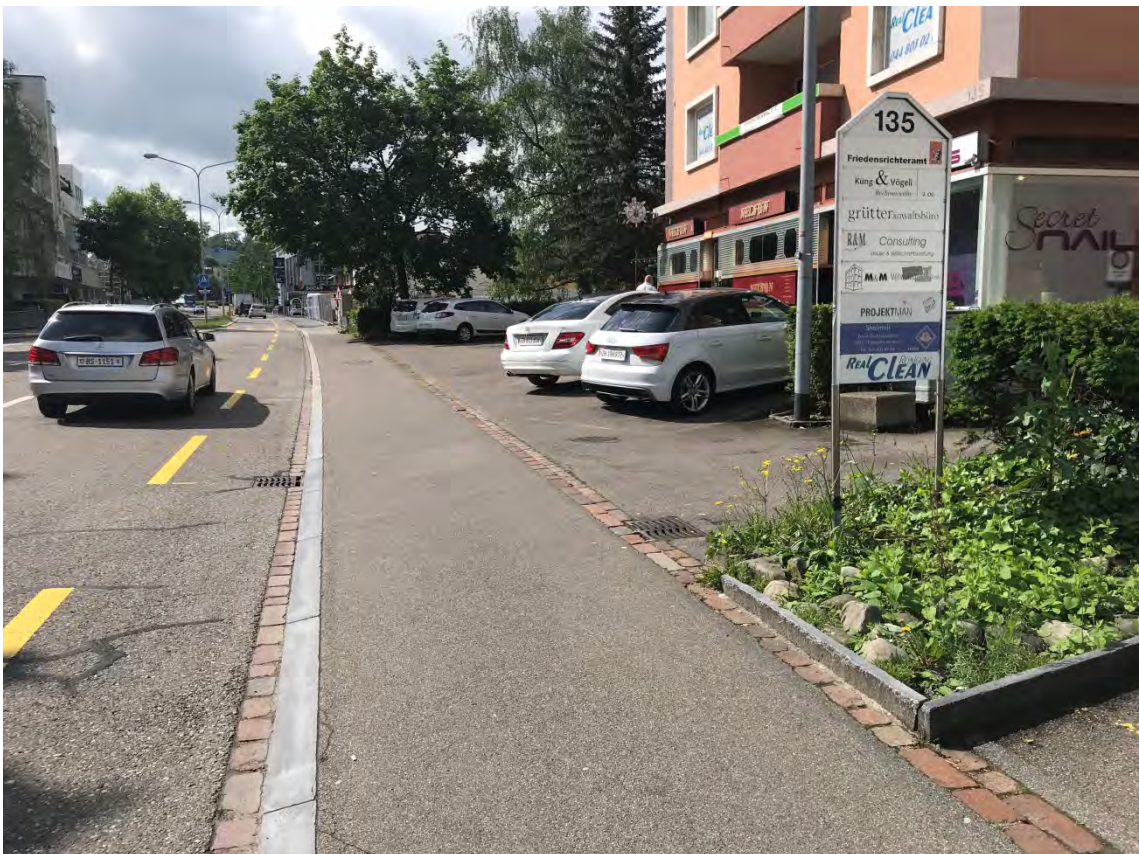
Foto 18 Parkplätze Schaffhauserstrasse Nr. 135 (km 27.250, Blickrichtung Kloten Bahnhof)
