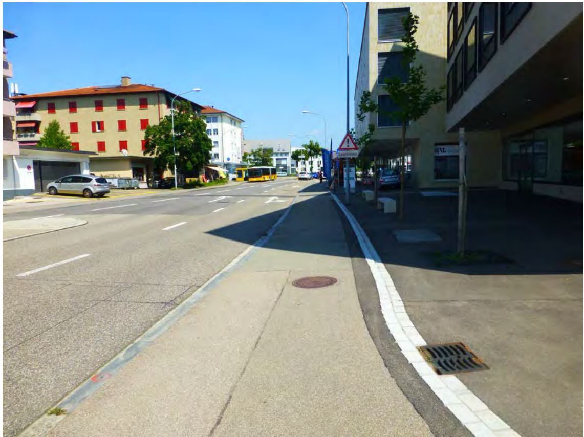
Foto 37 Flughafenstrasse Nr. 11 (km 27.450, Blickrichtung Bassersdorf)
