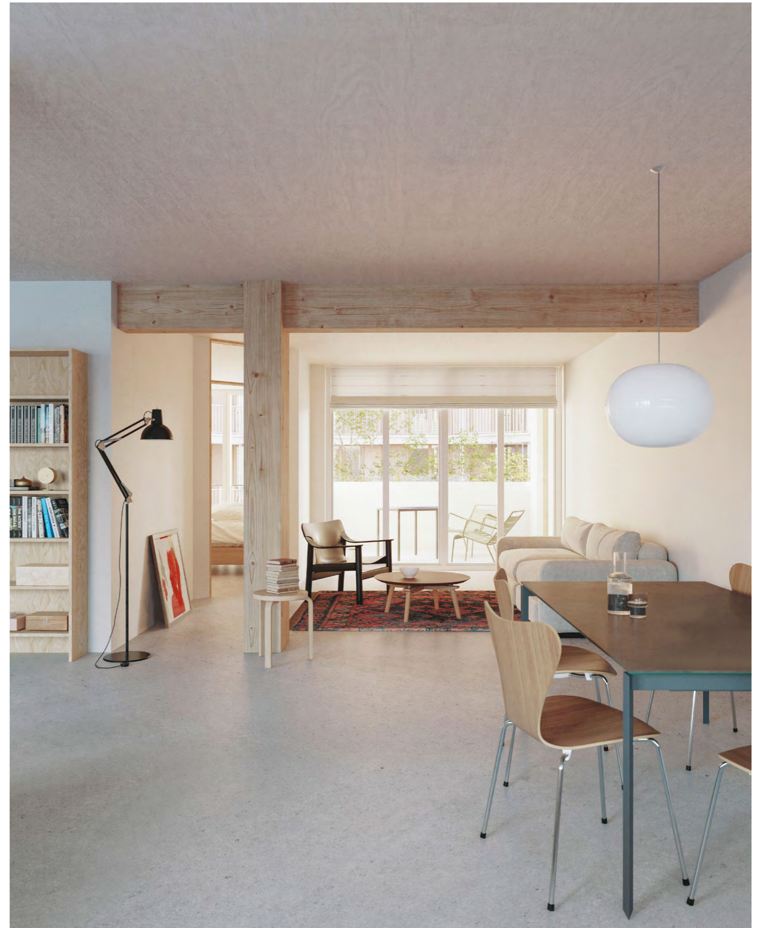
Die Wohnungen in den Obergeschossen des Langhauses sind zweiseitig, sowohl zum urbanen Strassenraum sowie zum ruhigen Hofraum ausgerichtet. Die Holzkonstruktion aus Stützen, Balken und Deckenelemente wird wo möglich sichtbar gelassen und trägt ihren Teil zur Wohnatmosphäre bei.
