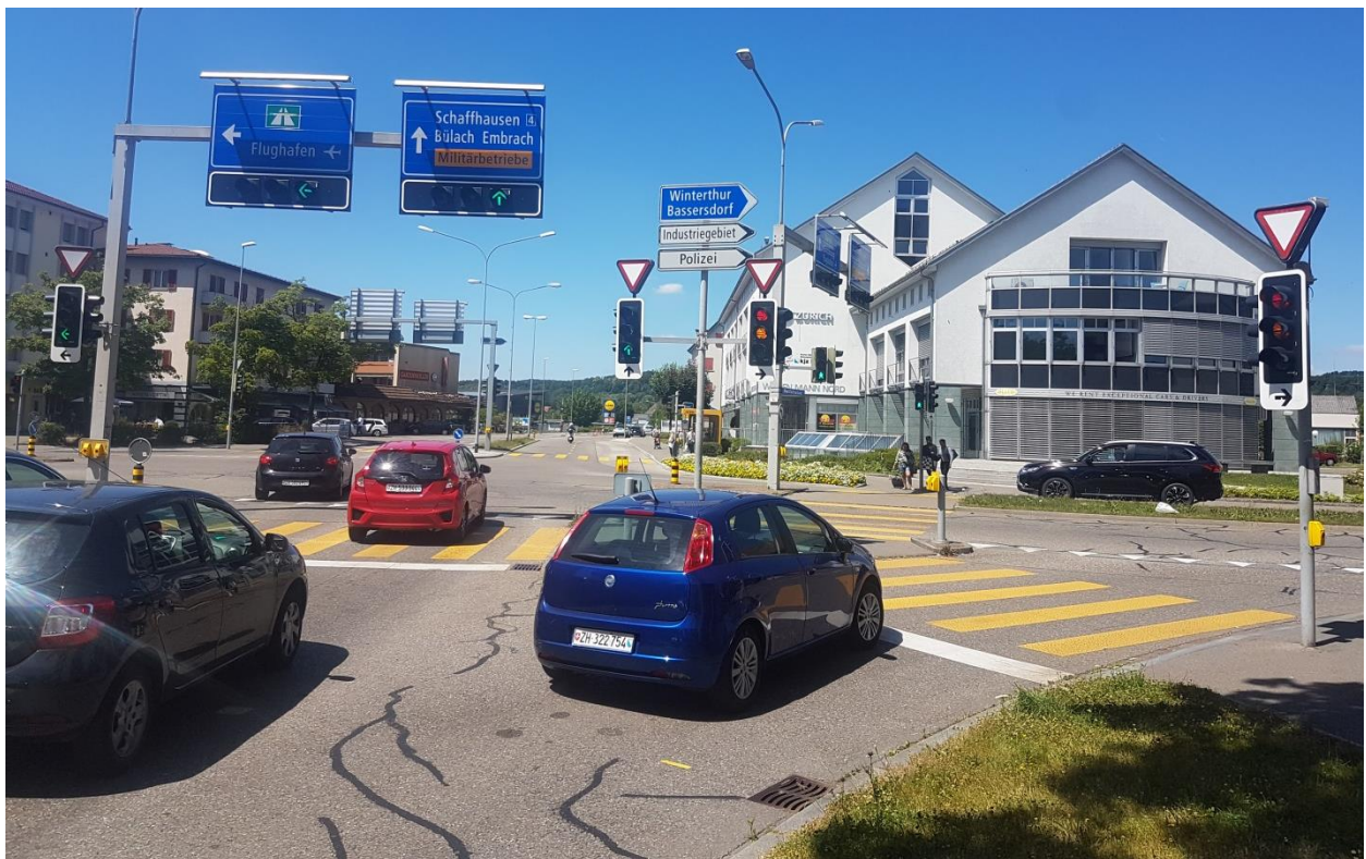
Abbildung 4: Ansicht Knotenzufahrt Schaffhauserstrasse (Süd-Zufahrt)
