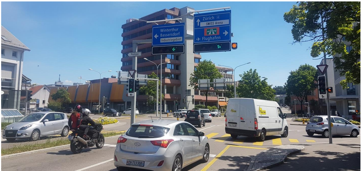
Abbildung 2: Ansicht Knotenzufahrt Schaffhauserstrasse (Nord-Zufahrt)
