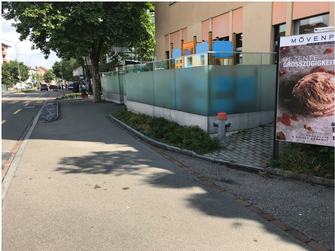
Foto 4 Terrasse Migros (km 27.110, Blickrichtung Bülach)
