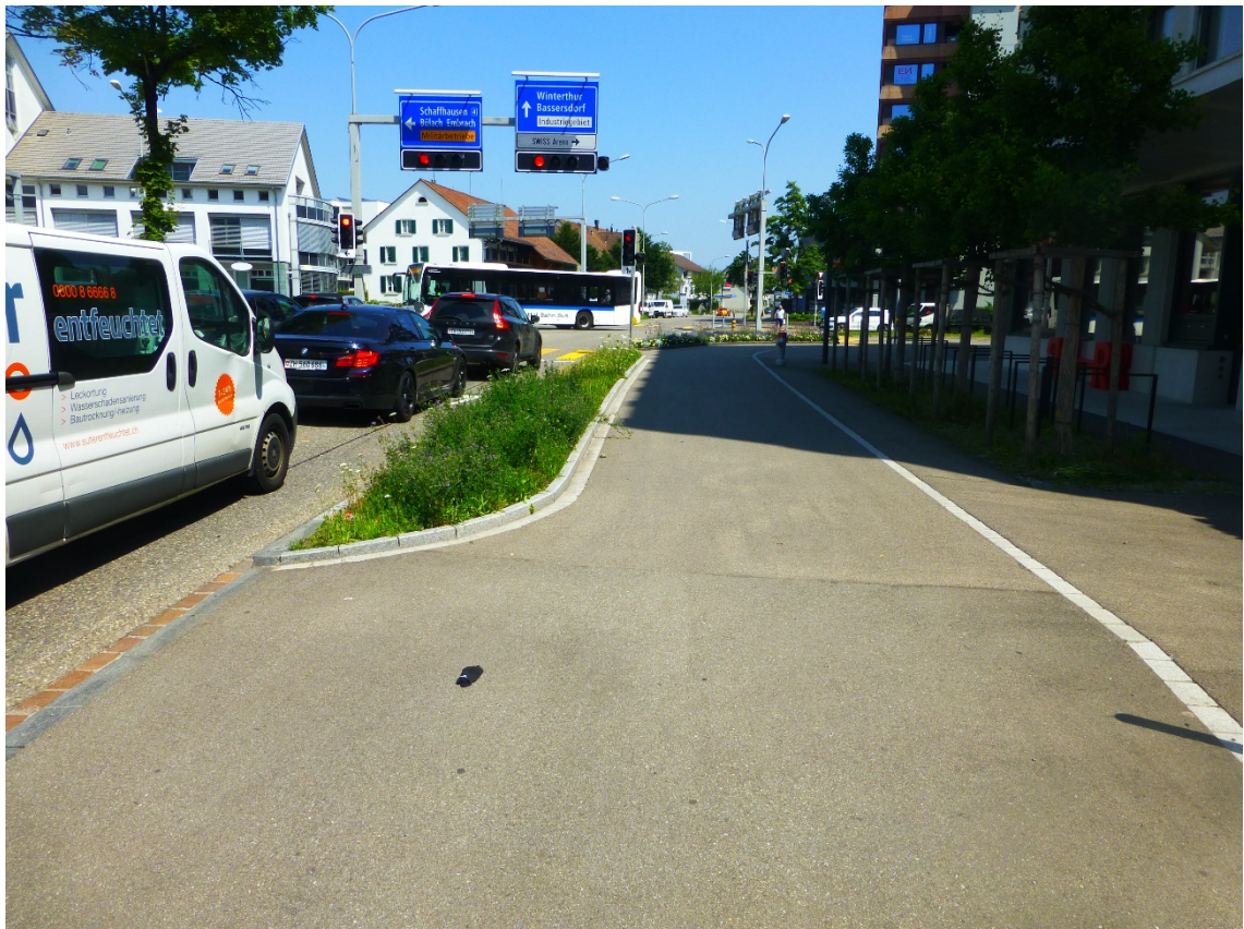
Foto 38 Flughafenstrasse Nr. 5 (km 27.450, Blickrichtung Bassersdorf)
