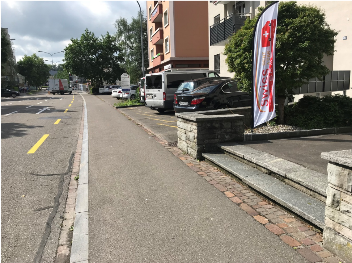
Foto 17 Parkplätze Schaffhauserstrasse Nr. 135/137 (km 27.280, Blickrichtung Kloten Bahnhof)
