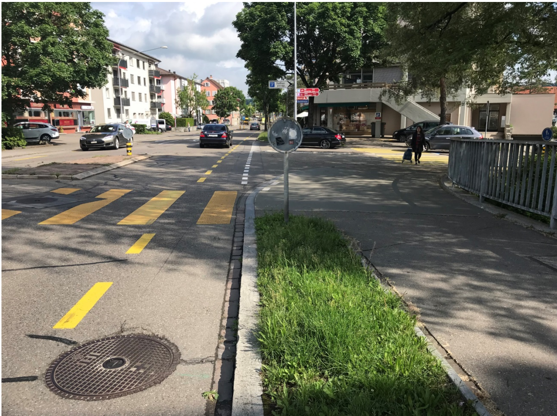
Foto 6 Brücke Altbach + Knoten Bachstrasse (km 27.200, Blickrichtung Bülach)
