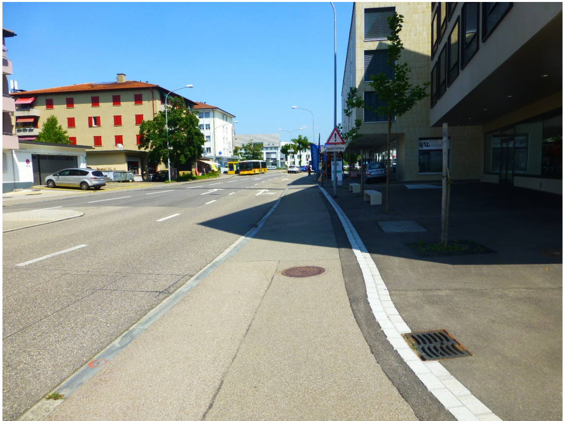
Foto 37 Flughafenstrasse Nr. 11 (km 27.450, Blickrichtung Bassersdorf)
