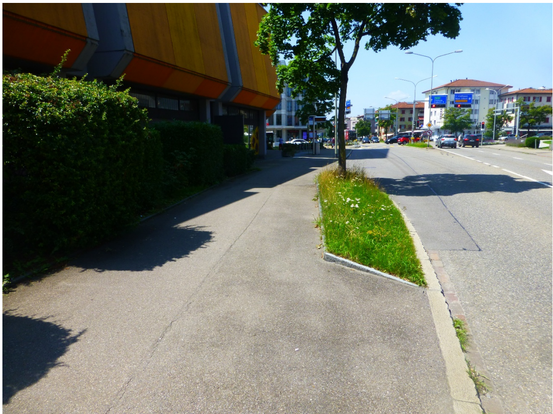
Foto 26 Schaffhauserstrasse Nr. 146 (km 27.410, Blickrichtung Flughafen)
