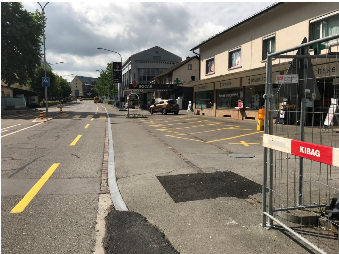
Foto 20 Parkplätze Schaffhauserstrasse Nr. 125 (km 27.170, Blickrichtung Kloten Bahnhof)
