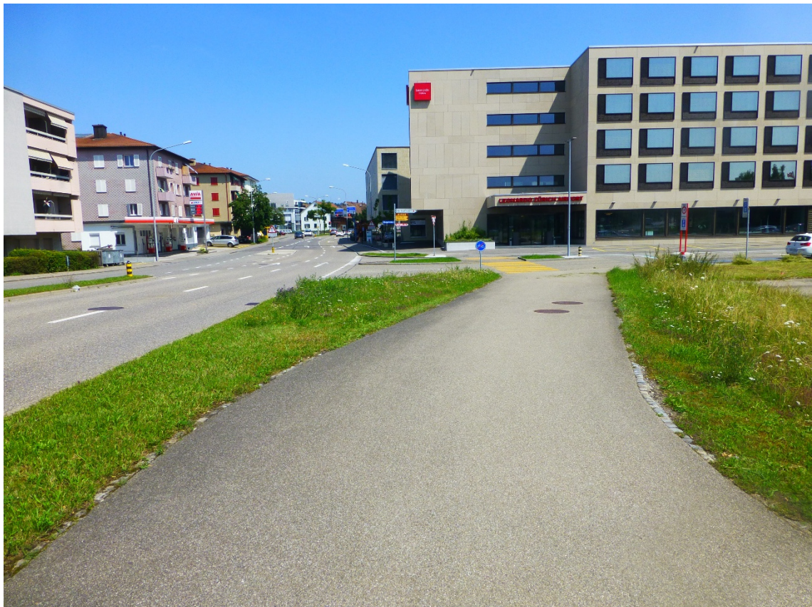
Foto 36 Flughafenstrasse Nr. 14 (km 27.450, Blickrichtung Bassersdorf)
