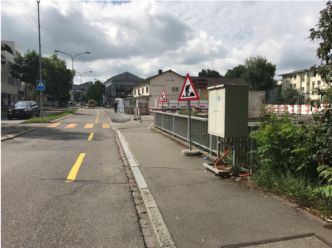
Foto 19 Brücke Altbach (km 27.220, Blickrichtung Kloten Bahnhof)
