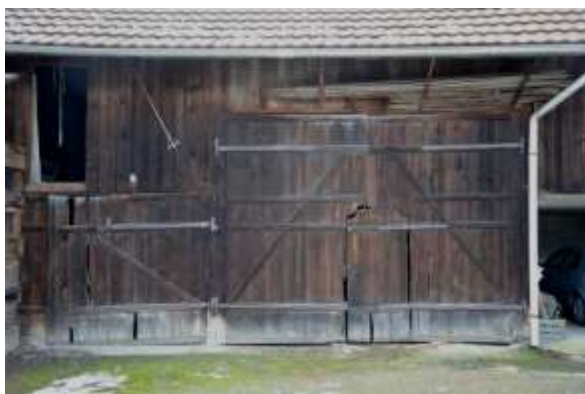
Abb. 82: Östliche Trauffassade, Tenntor.
