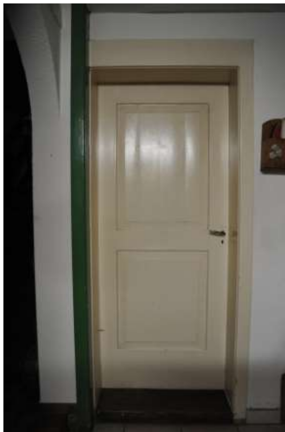
Abb. 57: Zweifeldrige Rahmentür mit abgeplatteten Füllungen zu Raum NNN. Blick nach Nordosten.
