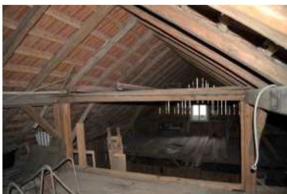
Abb. 103: Dachwek mit Kehlbalkenzange, Blick nach Norden.
