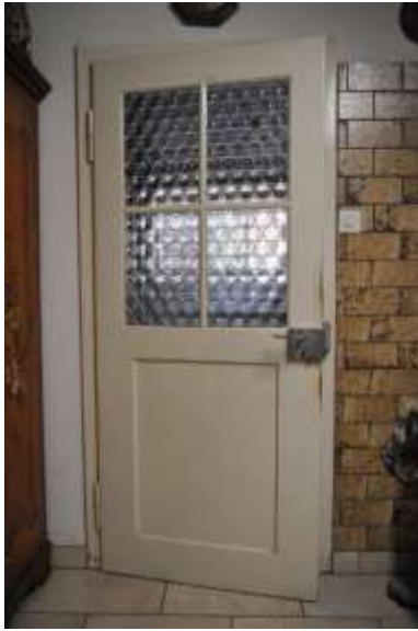
Abb. 53: Küche 005 mit Tür aus den frühen 1940er Jahren. Blick nach Osten.
