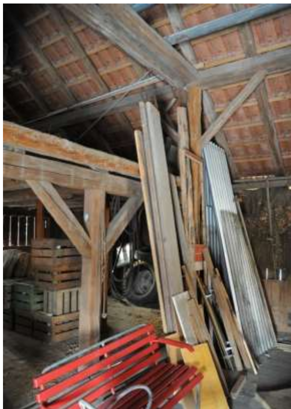
Abb. 106: Dachwerk mit Q2, Blick nach Westen.
