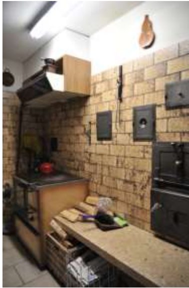
Abb. 54: Küche 005 mit Ofeneinfeuerung in der südlichen Binnenwand von 1941/42. Blick nach Südosten.
