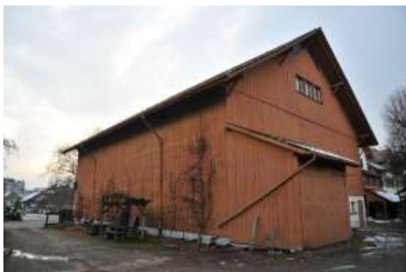
Abb. 25: Östliche Trauffassade des Ökonomiegebäudes mit Bretterschalung.
