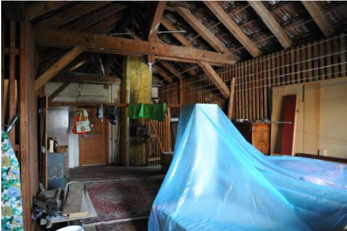
Abb. 69: Dachgeschoss, Blick nach Süden.
