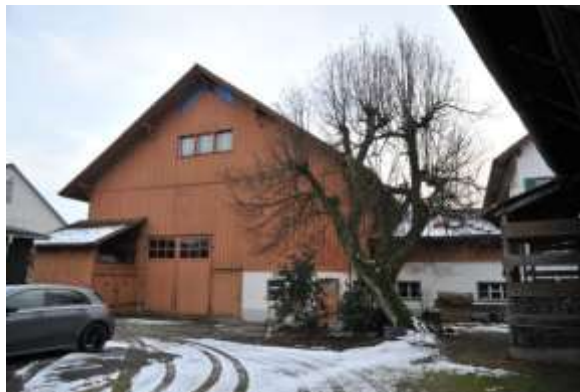
Abb. 24: Nördliche Giebelfassade der Ökonomie mit zweigeschossigem Verbindungsbau zum Wohnhaus.
