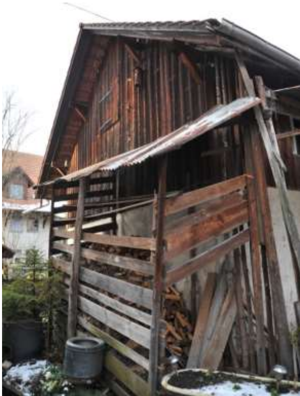
Abb. 84: Südliche Giebelfassade mit gemauertem Erdgeschoss und Bretterschalung.
