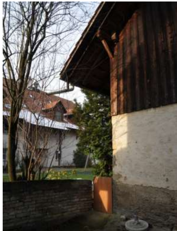
Abb. 85: Südliche Giebelfassade mit gemauertem Erdgeschoss.
