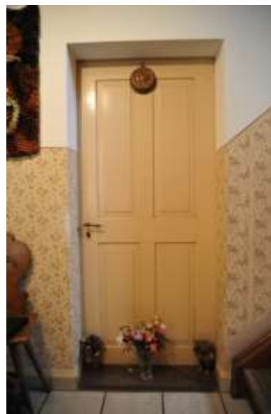
Abb. 37: Treppenhaus 001, vierfeldrige Rahmentür mit abgeplatteten Füllungen zu Raum 009. 2. Hälfte 19. Jh. Blick nach Westen.
