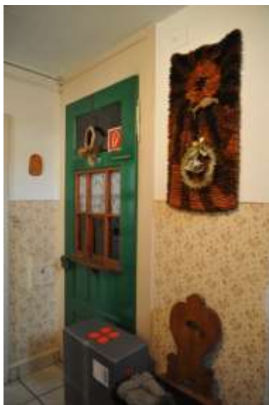
Abb. 38: Treppenhaus 001, veränderte, ehemals vierfeldrige Rahmentür mit liegenden und stehenden Feldern zu Raum 006.
