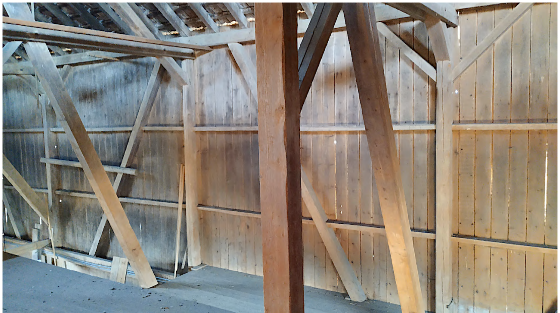
Fachwerkaussenwand mit schmal dimensionierten Riegelzügen und massiven Ständern und Streben.
