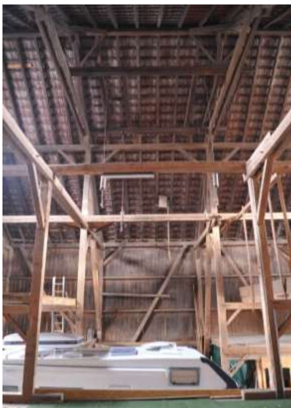
Abb. 78: Ökonomie, Blick in das Dachwerk nach Osten mit Q2 links und Q3 rechts.
