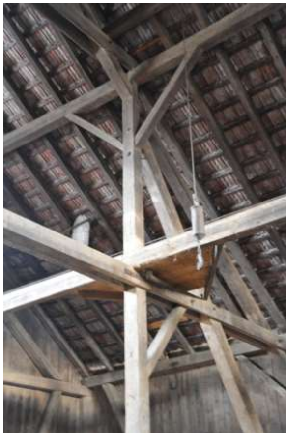
Abb. 77: Ökonomie, Blick in das Dachwerk nach Nordosten mit durchlaufendem Ständer und Kombination einer liegenden Stuhlsäule (Q2).
