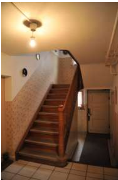
Abb. 36: Treppenhaus 001 von 1941. Blick nach Norden.
