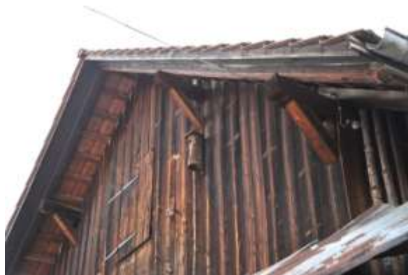
Abb. 83: Verschalte südliche Giebelfassade im Giebelfeld.
