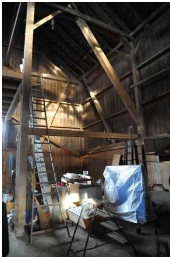
Abb. 73: Ökonomie mit geschossübergreifendem Ständer. Blick nach Norden.
