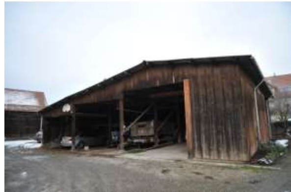
Abb. 89: Südfassade des ehemaligen Freiluftstalls. Die Öffnungen sind in der Höhe gestaffelt. Die übrigen Fassaden sind vertikal verschalt.
