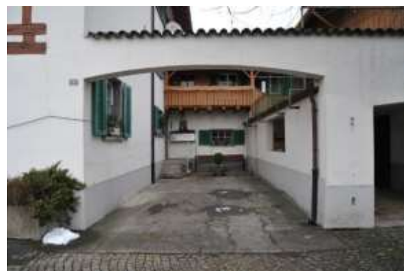
Abb. 26: Eingangssituation von der Dorfstrasse mit Torbogen, Innenhof und der verputzten Trauffassade des Wohnhauses
