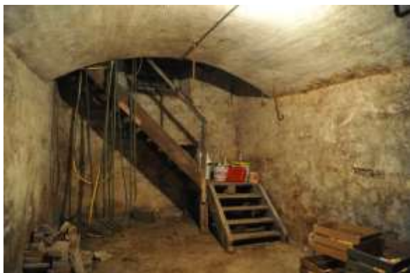
Abb. 90: Gewölbter Keller von 1882, Blick nach Südosten.
