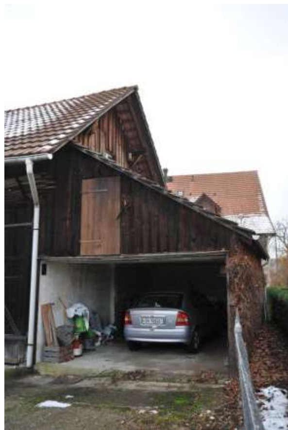
Abb. 87: Schopfanbau nach Norden mit Bretterschalung.
