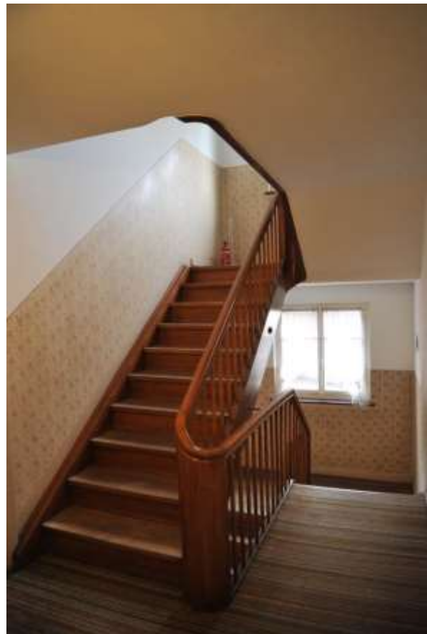
Abb. 61: Treppenhaus von 1941, Blick nach Norden.
