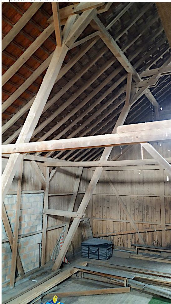
Blick auf die mittels Zangen ausgebildeten Sprengwerke in den Binderebenen.
