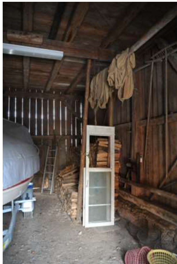
Abb. 100: Nördliche Querzone, Blick nach Nordwesten.
