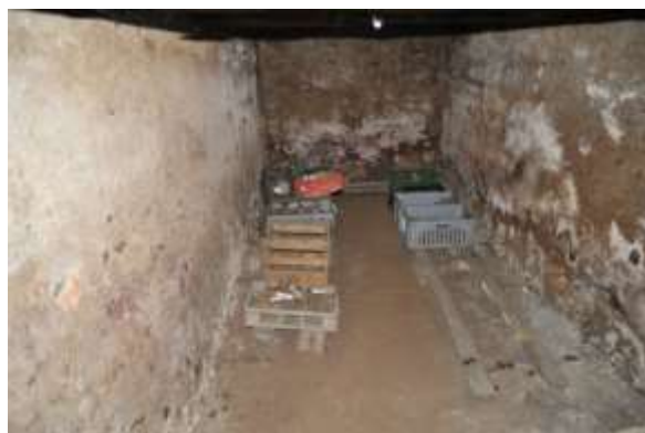
Abb. 93: Keller von 1976, Blick nach Nordosten.
