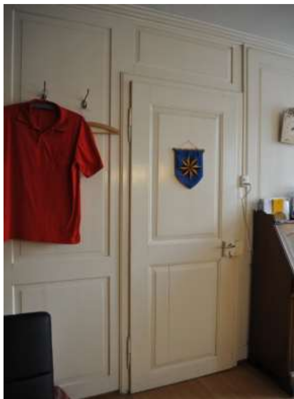
Abb. 51: Nebenstube 004 mit Wandtäfer und Tür zur Stube 003 mit abgeplatteten Füllungen, 1. Hälfte 19. Jh. Blick nach Südosten.
