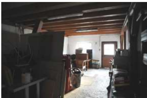
Abb. 74: Ökonomie, Lagereinbau im Stall von 2012. Blick nach Süden.
