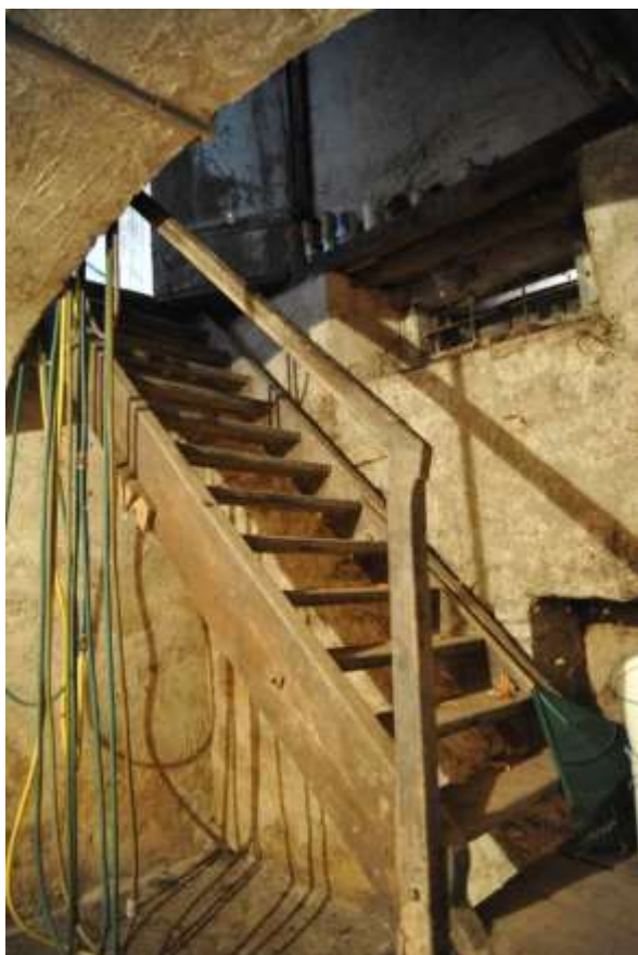
Abb. 92: Gewölbter Keller mit Treppenabgang. Blick nach Osten.
