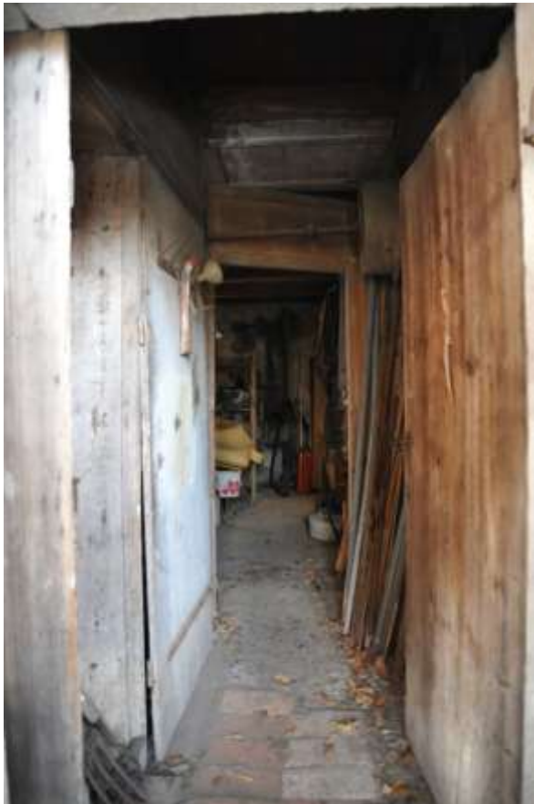
Abb. 94: Schopf, südliche Querzone, Blick nach Nordwesten. Links der Kellerabgang.
