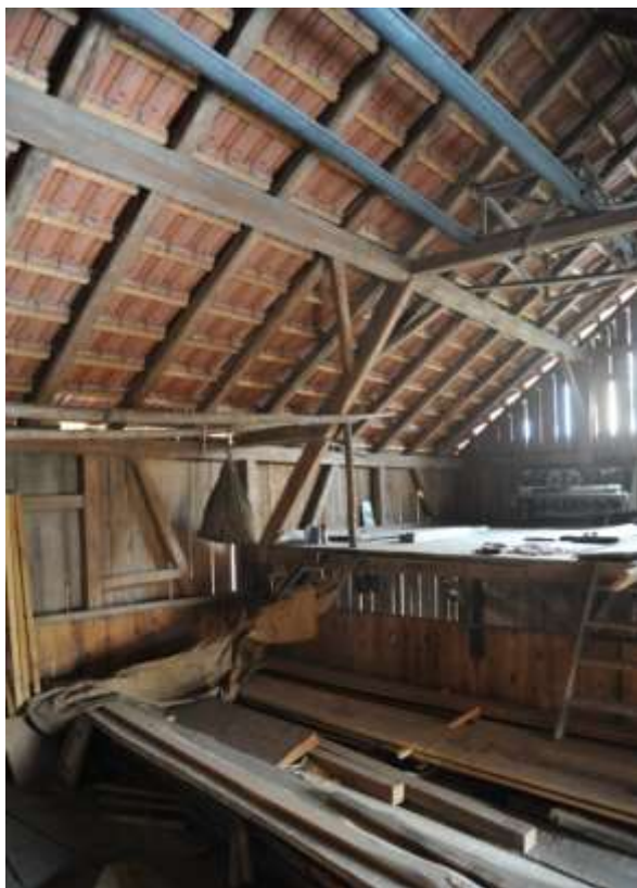
Abb. 105: Dachwerk mit liegendem Stuhl in Q3. Blick nach Norden.
