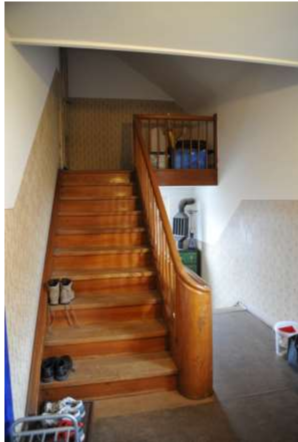
Abb. 68: Treppenhaus, Blick nach Norden ins Dachgeschoss.
