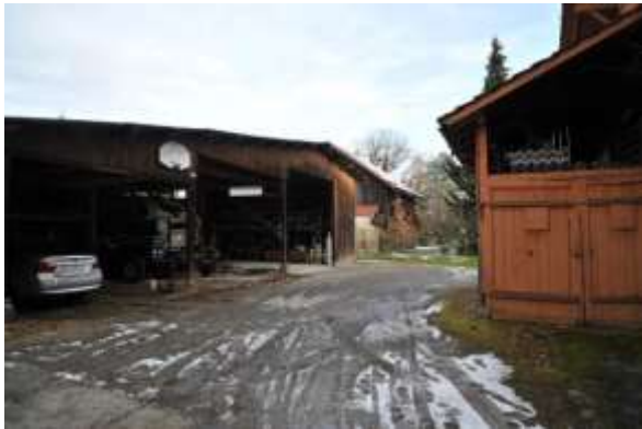
Abb. 88: Ehemaliger Freiluftstall / Schopf mit geöffneter Südfassade. Die übrigen Fassaden sind vertikal verschalt.
