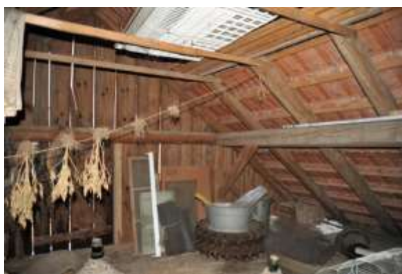
Abb. 104: Dachwerk mit südlicher Giebelwand, blick nach Südwesten.
