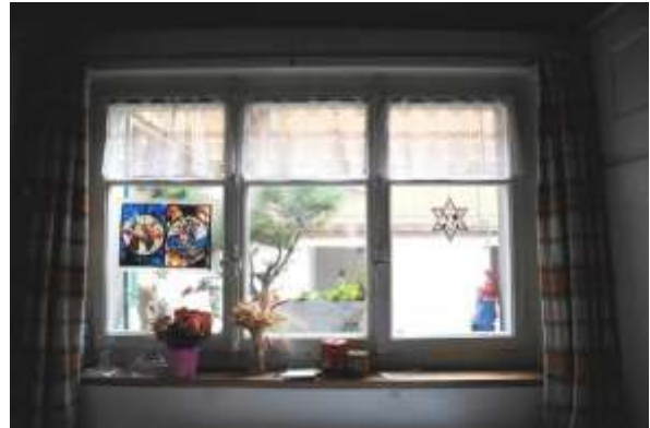
Abb. 41: Vorplatz 002, dreiteiliges Fenster von 1941.
