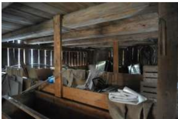
Abb. 101: Dachbalkenlage, Blick nach Südwesten.
