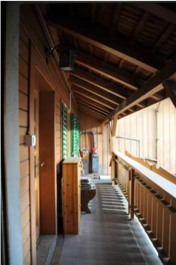
Abb. 64: Verbindungsbau mit Laube von 1941. Blick nach Osten.
