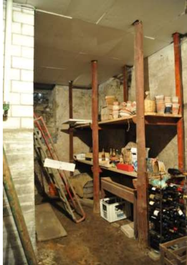
Abb. 33: Keller -101 mit Gestell und Bollensteinboden, wohl 1907. Links sekundärer Einbau mit Ziegelsteinmauerwerk, wohl Heizraum. Blick nach Nordwesten.
