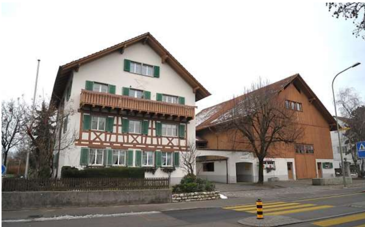
Abb. 22: Südliche Strassenfassade des Wohnhauses und der Ökonomie mit eingeschossiger Bogenverbindung der beiden Gebäude.
