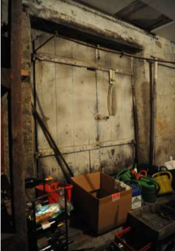
Abb. 32: Keller -101, externer Kellerabgang von Norden mit zwei-flüligem Tor, wohl 1907, Kammer 302. Blick nach Nordosten..
