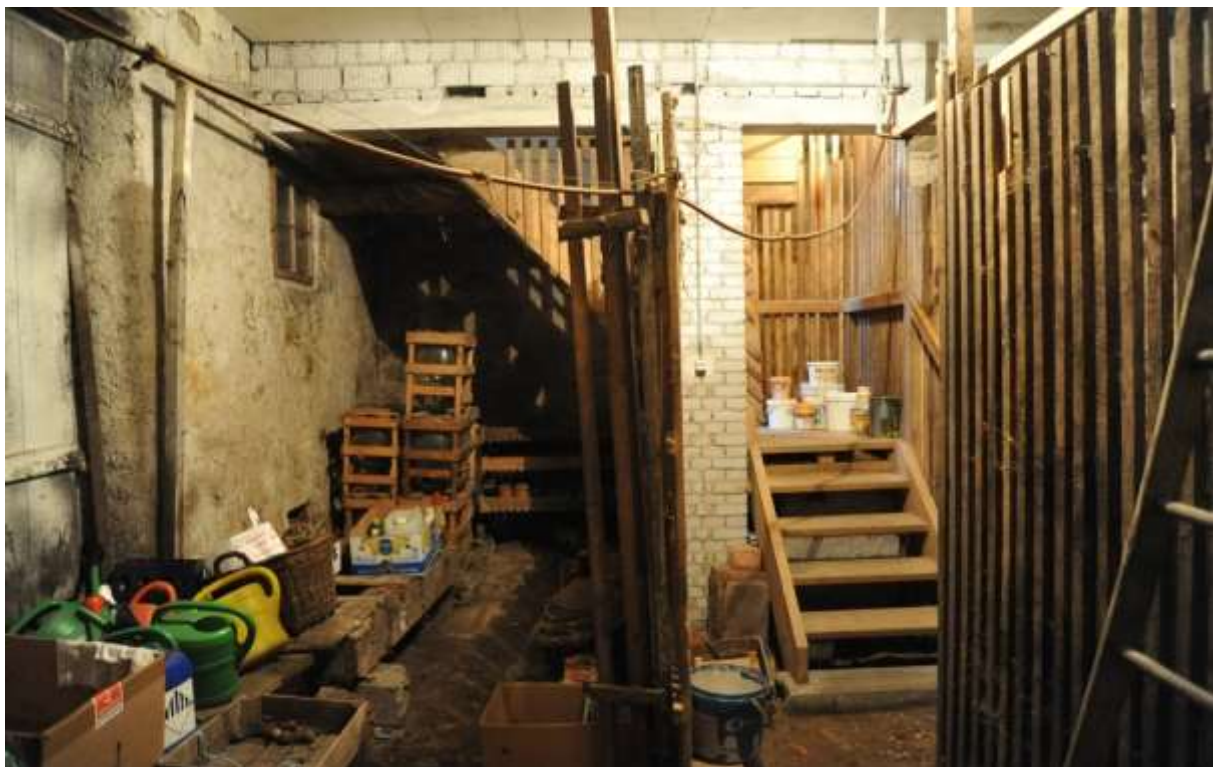
Abb. 31: Keller -101 von 1907, Binnengliederung aus Ziegel sowie Decke mit Dämmplatten nach 1941, Blick nach Osten.
