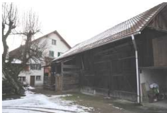
Abb. 81: Östliche Trauffassade, Blick nach Südwesten mit Wohnhaus im Hintergrund.
