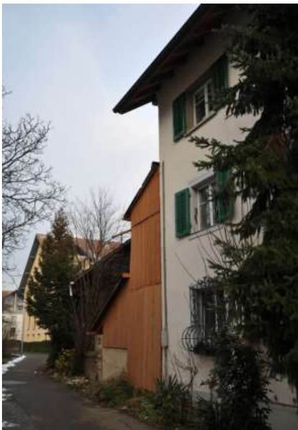
Abb. 29: Westliche Trauffassade des Wohnhauses mit verschaltem Lauben- und Abtrittanbau nach Norden.
