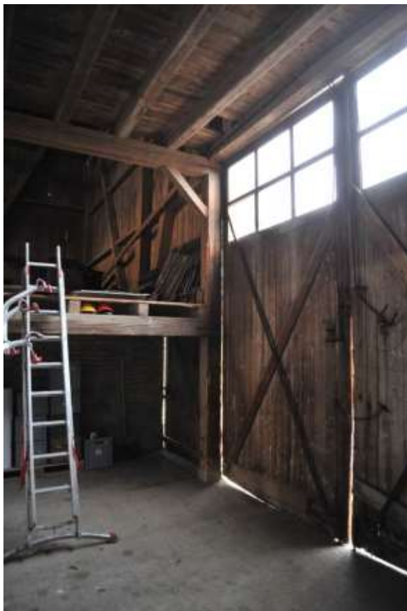
Abb. 72: Ökonomie mit Längstenn, Tenntor nach Norden, 1941-43. Blick nach Nordwesten.
