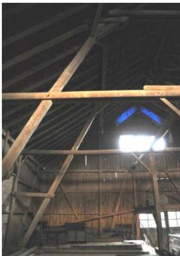
Abb. 79: Ökonomie, Blick in das Dachwerk nach Süden.
