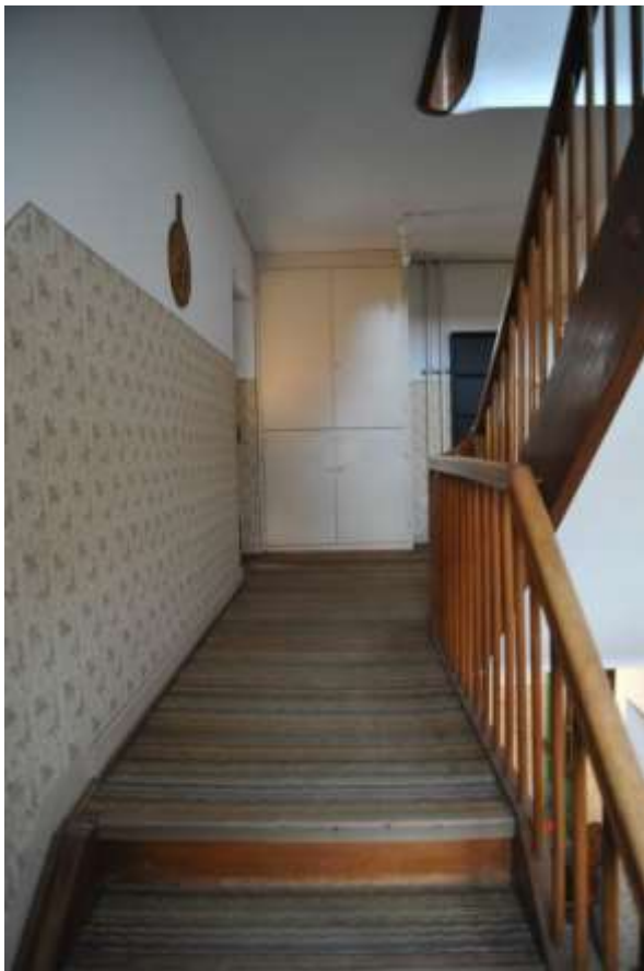
Abb. 60: Treppenhaus von 1941, Blick nach Süden.
