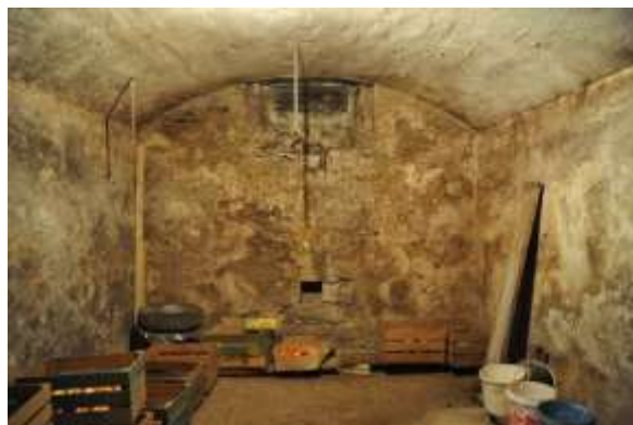
Abb. 91: Gewölbter Keller von 1882 nach Nordwesten.
