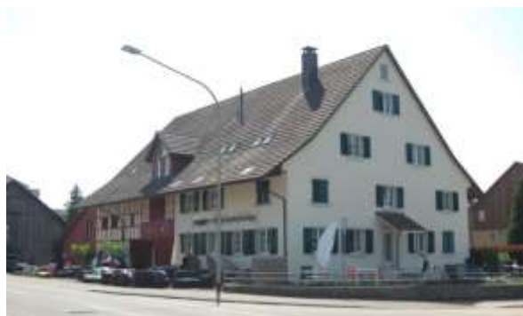
Abb. 15: Blick nach Südosten an die Kreuzung der Dorfstrasse mit der Petergasse und dem Gebäude Dorfstrasse 34.
