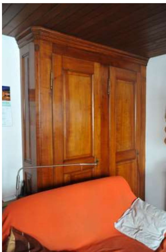
Abb. 46: Stube 003, Einbauschränk mit abgeplatteten Füllungen und Fischbändern mit kegelförmigen Enden, Mitte / 2. Hälfte 19. Jh. Blick nach Nordosten.
