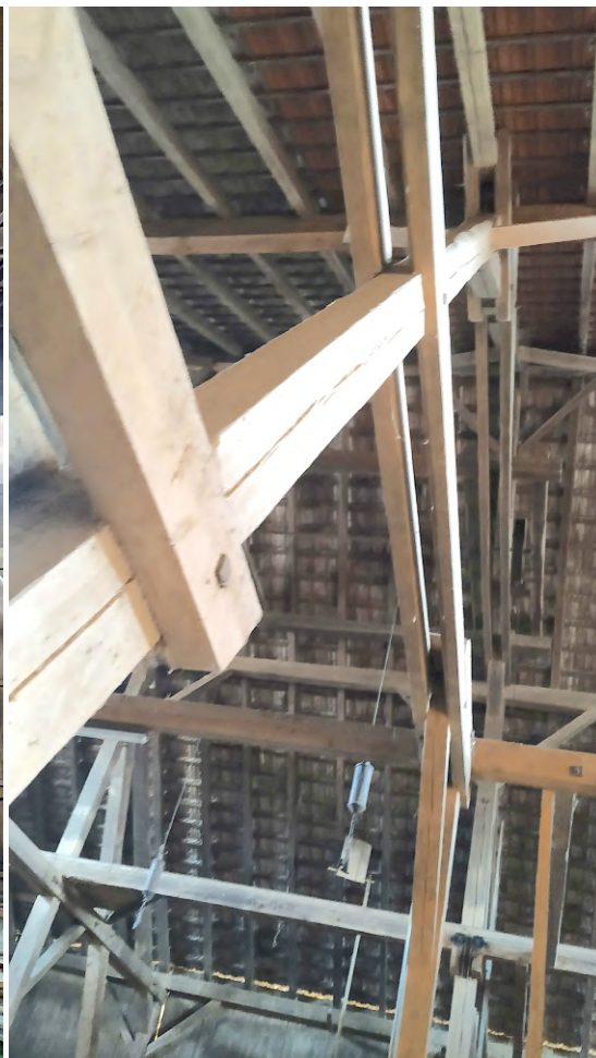
Blick auf die mittels Zangen ausgebildeten Sprengwerke in den Binderebenen.
